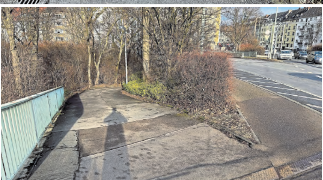
Das Drängelgitter auf der steilen Abfahrt ist von der Severinsbrücke aus nicht erkennbar.
