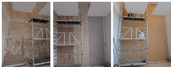
Abb. 6: Arbeitsschritte bei der Umsetzung der Innendämmung in einem Gebäude der UdK Berlin; Foto: UdK Berlin, Fachgebiet VPT
