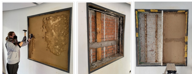
Abb. 7: Rückbau der Testfassadenprüfstände aus der Vorlaufforschung im Rooftop-Experimentalgebäude der UdK Berlin; Foto: UdK Berlin, Fachgebiet VPT
