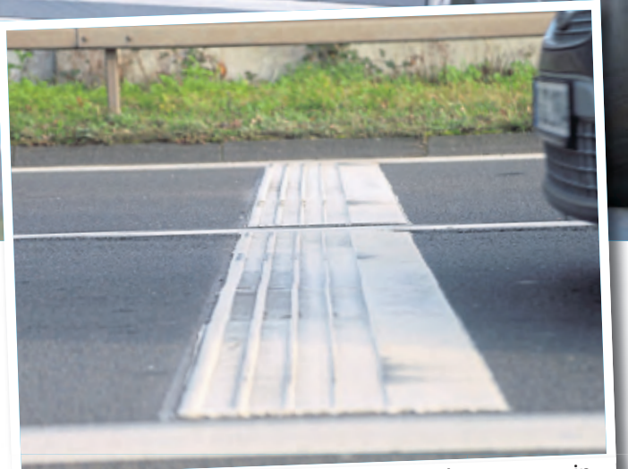
In Deutschland werden die Rüttelstreifen bislang nur vereinzelt eingesetzt.
