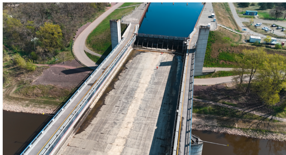
Drohnenaufnahme Widerlager Ost und Revisionsverschluss
