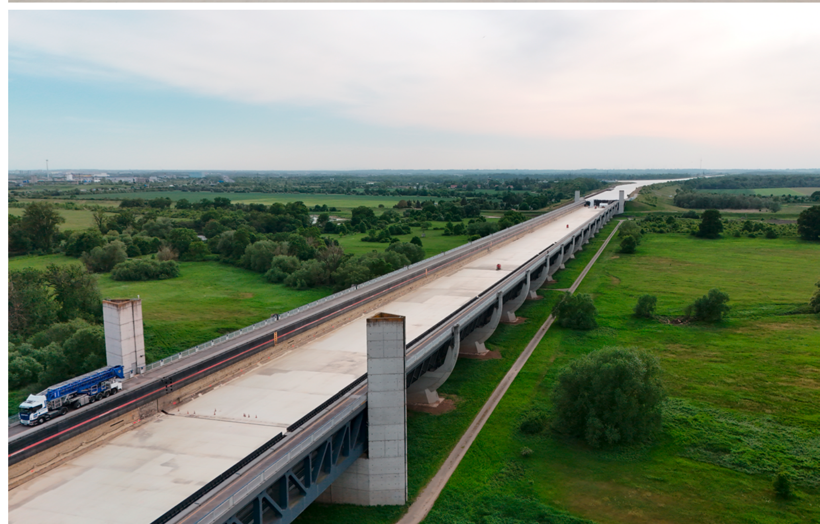
Oben: Blick von der Sohle des Troges in die trockengelegte Kanalbrücke Unten: Drohnenaufnahme der trockengelegten Vorlandbrücke
