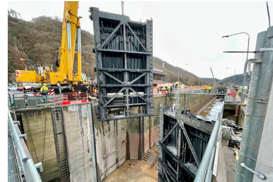
Einkranen der beiden neuen Torflügel
