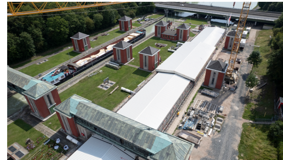
Deckelung der Schleusenkammer
