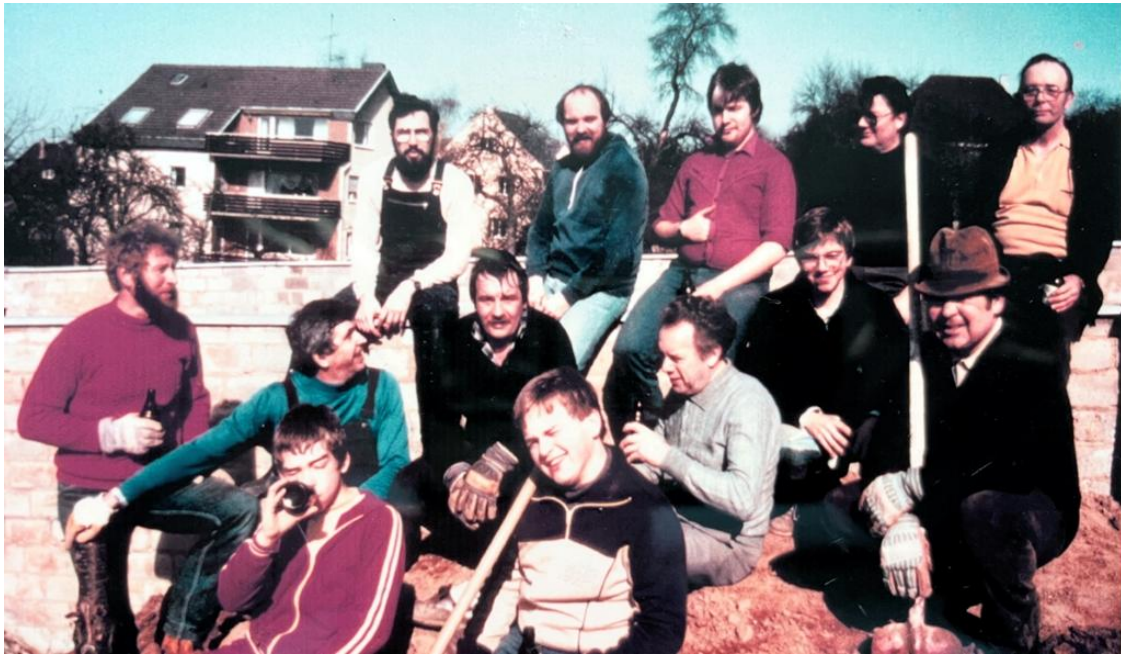
Bild: Tieferlegung KK-Stand
