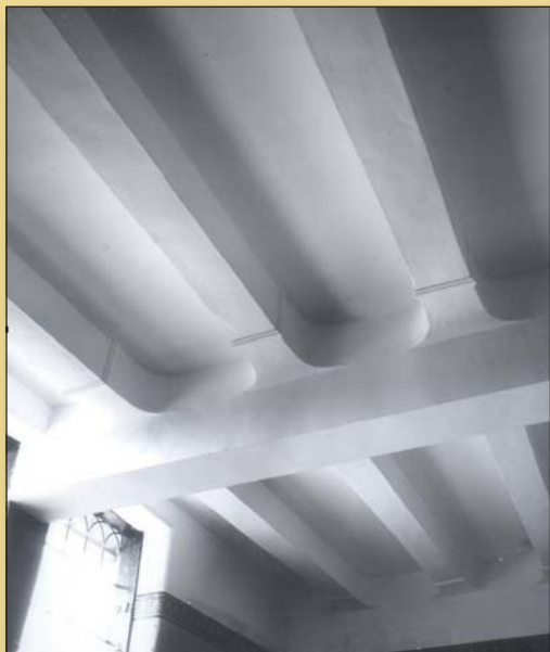
Damianshof, im Inneren, „Kölner Decken“ (noch ohne Ornamente in den Endwickeln), 1987.
