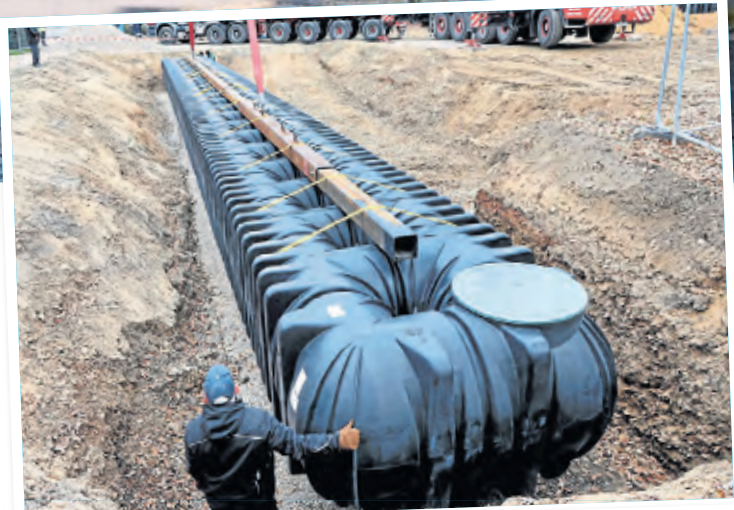
Anlieferung der relativ großen Zisterne im Stadtpark von Leichlingen. 65.000 Liter Wasser kann das Reservoir speichern. Foto: M. Wand
