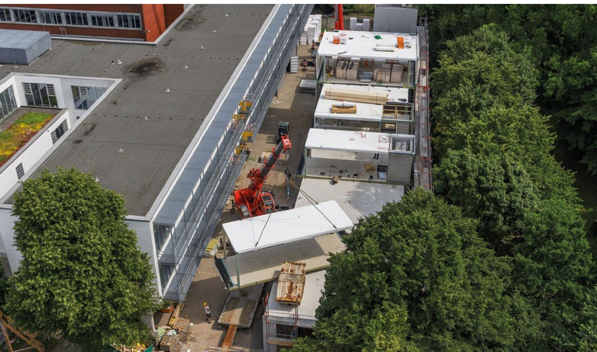
Von der Modulmontage bis zur Fertigstellung des Erweiterungsbaus vergingen vier Monate (Foto: Christian Haase)
