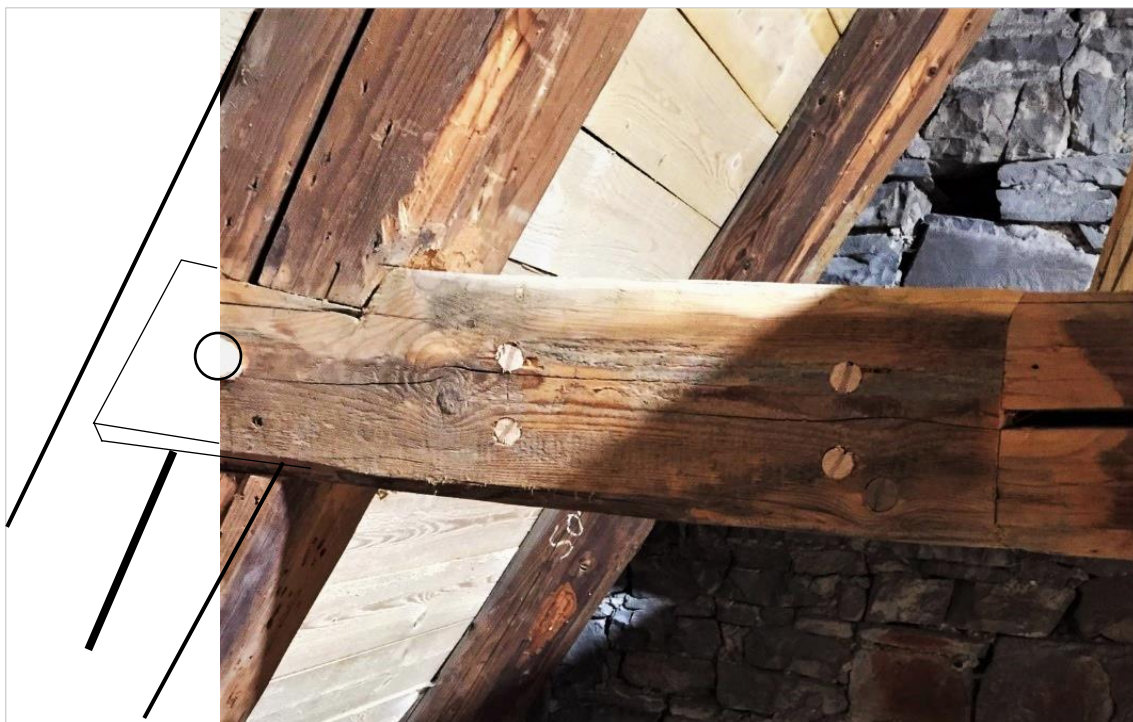
Abbildung 5-1 Sanierung eines Kehlbalkenanschlusses im Dach der Frankenberger Kirche (Frankenberger Plan 7, 38640 Goslar). (Bildnachweis IGP Gockel PartGmbH)
