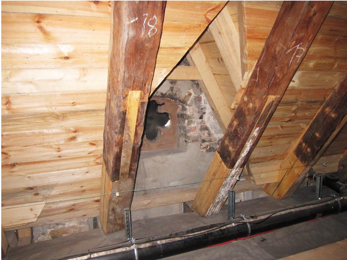
Abbildung 5-2 Sanierung der Sparrenfußpunkte im Dach des Rathauses Goslar (Markt 1, 38640 Goslar). (Bildnachweis IGP Gockel PartGmbH)
