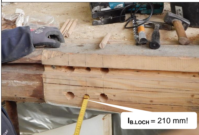
Überprüfung der Tiefe des Bohrloches
