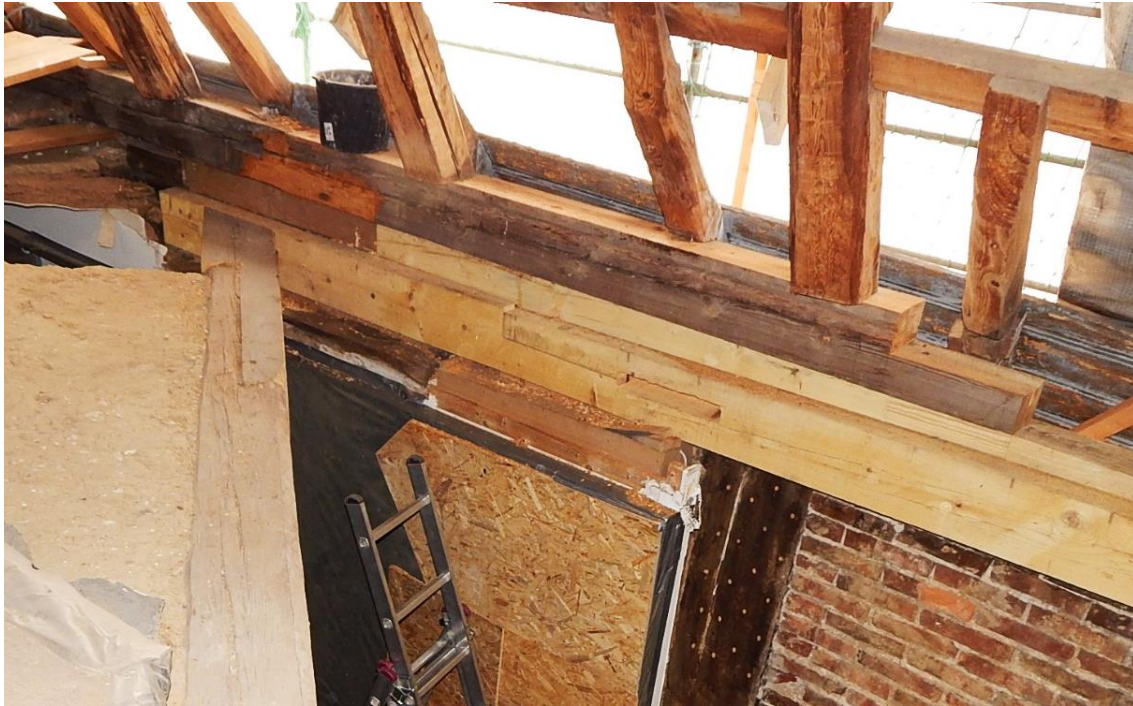
Abbildung 6-1 Sanierung der Deckenbalken im Gebäude der Handwerkskammer Braunschweig-Lüneburg-Stade (Burgplatz 2, 38100 Braunschweig). (Bildnachweis IGP Gockel PartGmbH)
