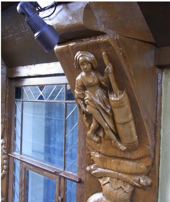
Abbildung 7-4 Fassade des Brusttuchs, Goslar (Hoher Weg 1, 38640 Goslar). Detail der Konsole. Statisch-beanspruchte „kosmetische Reparatur“. (Bildnachweis IGP Gockel PartGmbB)
