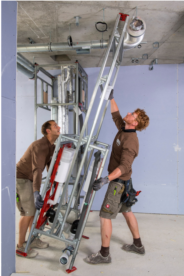
Abbildung 1 Montage eines vorgefertigten Trockenbau-Installationsregisters.
