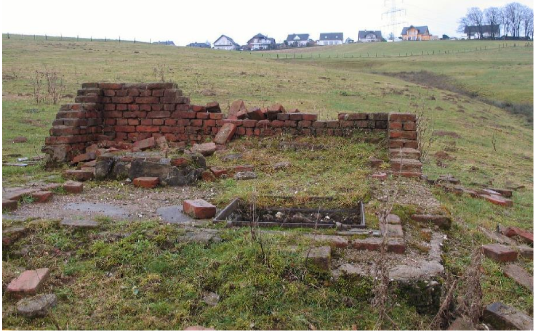
Blick auf das zerstörte Pumpenhäuschen mit dem verfüllten ( mit Ziegelsteinen ) Brunnenschacht. Im Hintergrund oben Wiehagen und rechts der Quellgraben. Foto 18.1.2011 S. Berg
