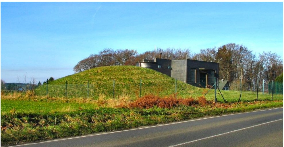
Foto 71 oben Mai 1970 vom eingeschalteten Wasserbehälter (Rundbau) in Westhofen und unten ein Autorenfoto vom 03.12.2015 vom, mit Erde abgedeckten, Hochbehälter und Eingangsgebäude.
