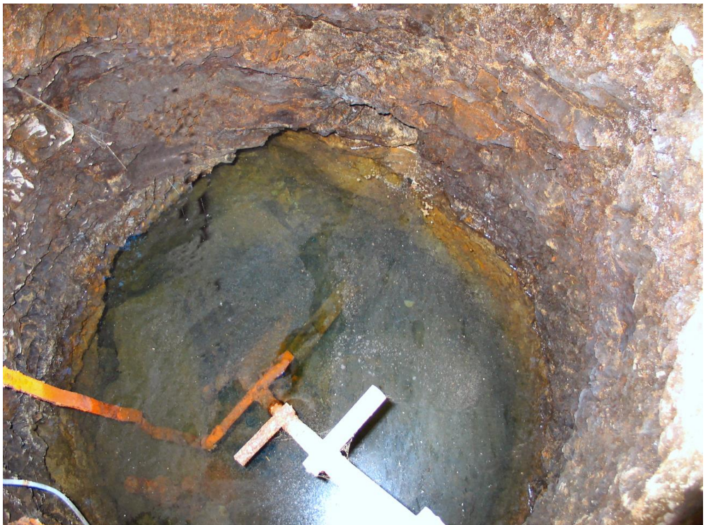
Foto Autor vom 01.02.2016. Eine Art Leiter führt hinab. Ein altes angerostetes Rohr diente der früheren Wasserentnahme.
