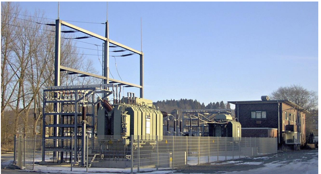
Umspannwerk in Kleinenichen. Ab 1974 hat man 2 Transformatoren mit je 30 MVA im Einsatz. Foto vom 24.02.2000 von Siegfried Berg
