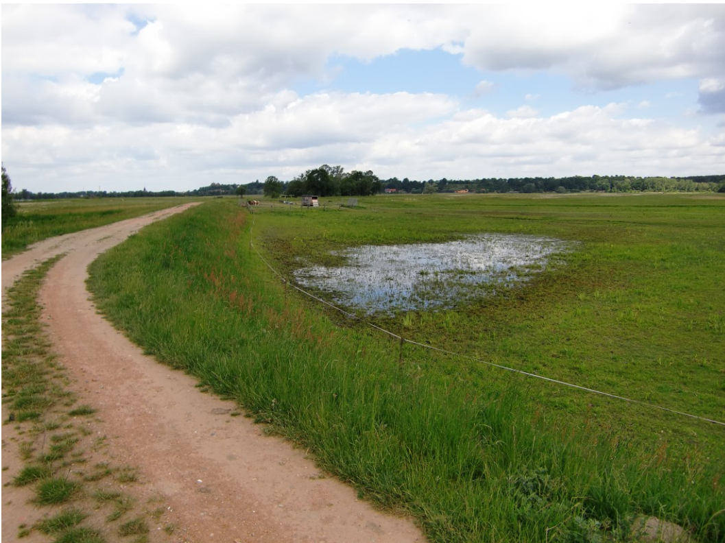
Abb. 5: Durch Schlitzung von Deichanlagen (links) werden Überflutungsflächen (rechts) wieder zurückgewonnen (Foto: R. Buchta)
