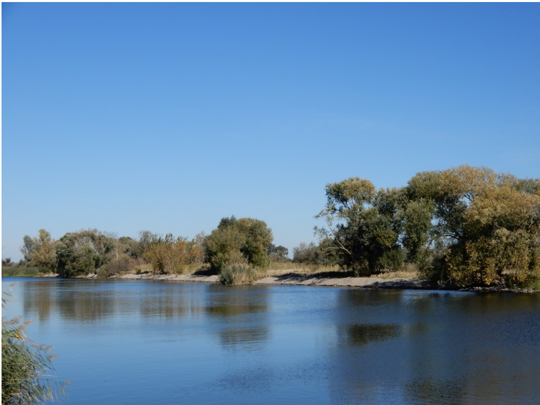
Abb. 3: Havelufer direkt nach dem Rückbau des Deckwerkes (Foto: R. Buchta)
