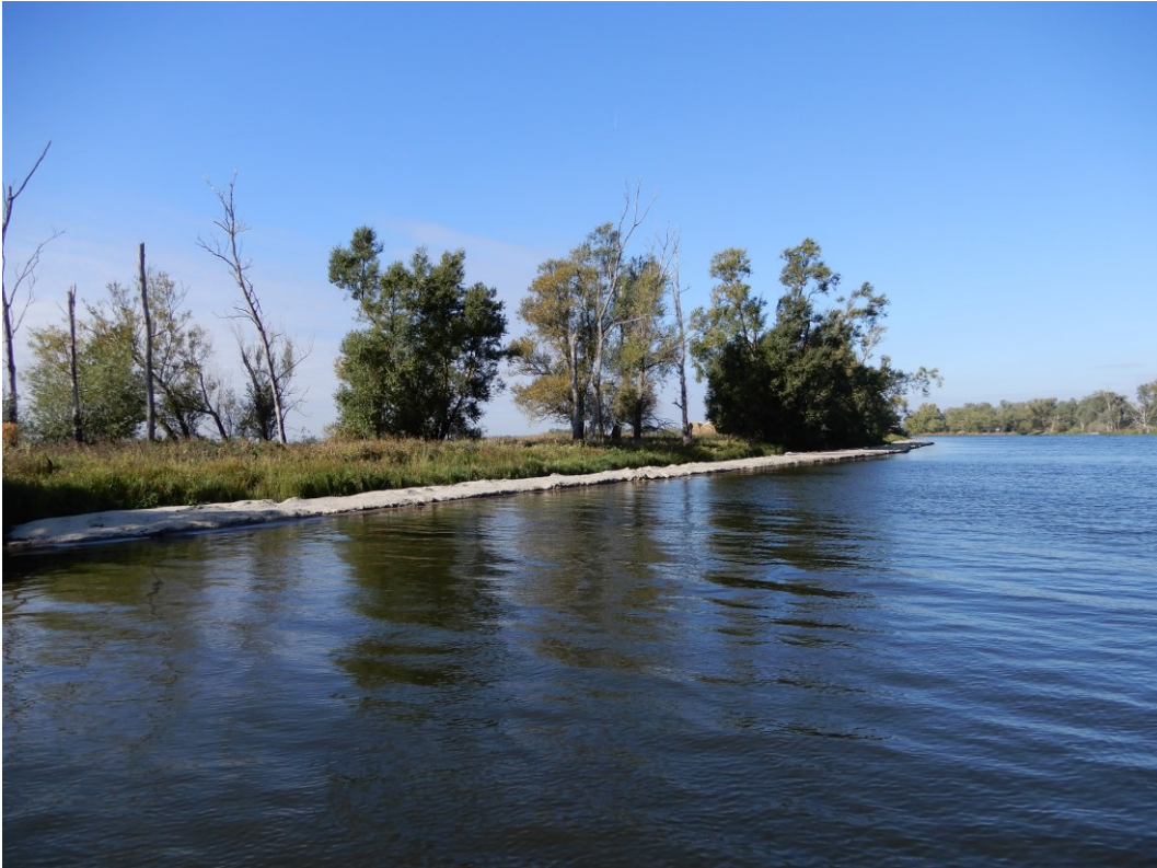
Abb. 8: Deckwerksübersandung und Initialisierung von Flachwasserbereichen im Rahmen der Gewässerunterhaltung der WSV (Foto: R. Buchta)
