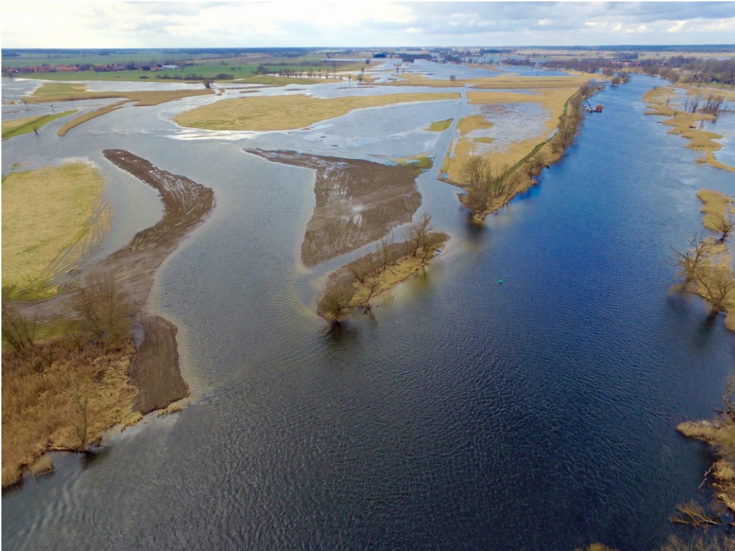
Abb. 4: Absenkung von Uferverwallungen und Anschluss von Flutrinnen, im Hintergrund Rückbau von Deckwerken (Foto: MANU IFA)
