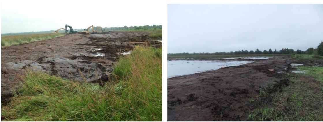
Abb. 5 + 6: Bau einer Verwallung (Quelle: Stiftung Naturschutz Schleswig-Holstein)
