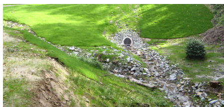
Dank Rückhaltebecken ist der planbare Hochwasserschutz gewährleistet.
