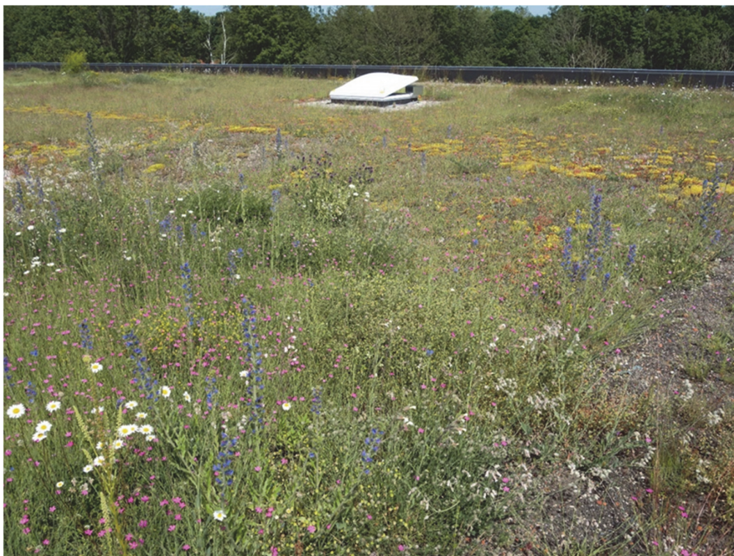
Abb. 3: Teilbereich des 1 ha großen mit regionaltypischen Wildpflanzen begrüntes Dachs einer Logistikhalle in Wagenfeld, Landkreis Diepholz ca. 20 Monate nach der Ansaat. Halb-intensive Begrünung auf einer „Anhögelung“ mit 15 cm Substratmächtigkeit (Vordergrund, links) und Extensivbegrünung mit 10 cm Substrat (Hintergrund und rechts, Juni 2021). (Foto: D. Jeschke)
