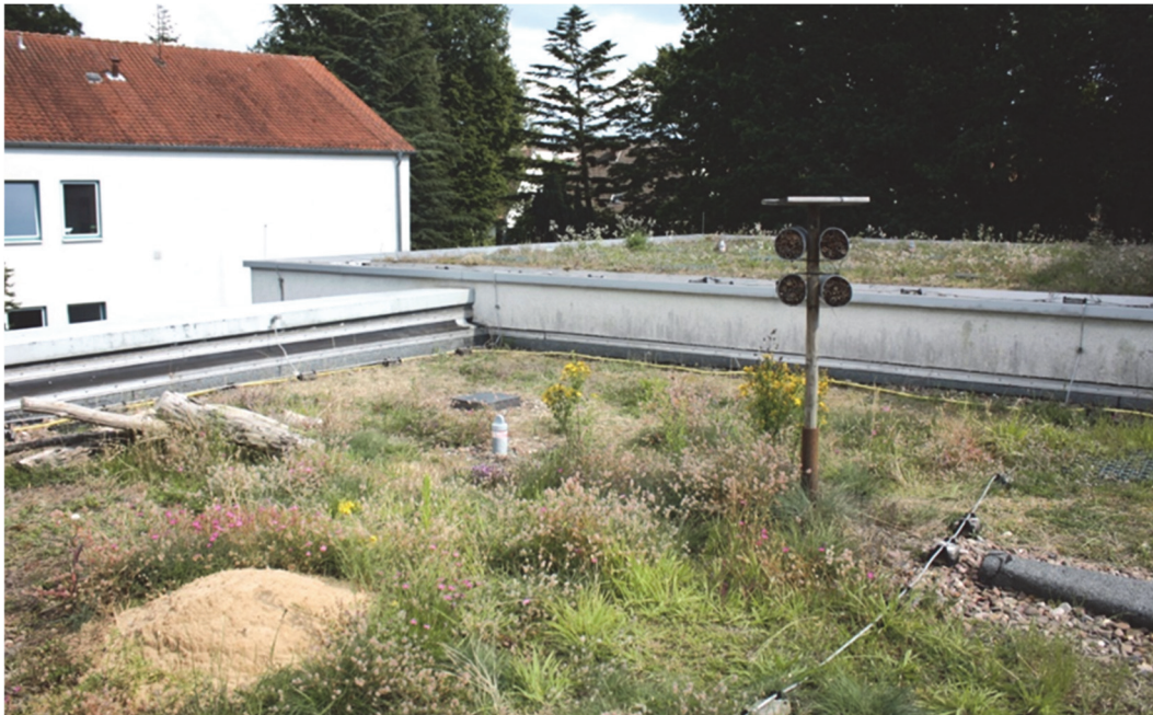
Abb. 4: Mit Pflanzenarten nordwestdeutscher Sandtrockenrasen begrüntes Dach eines Hörsaalgebäudes der Hochschule Osnabrück, Campus Haste, mit Sandlinsen, Totholz und hohlen Stängeln als Niststrukturen für blütenbesuchende Insekten. (Foto: F. Päscher)
