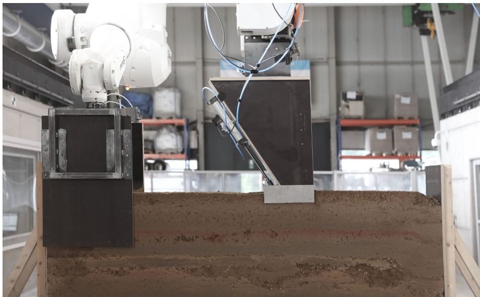
Abbildung 14: Kooperativer Prozess für die Materialbeschickung und Materialverdichtung
