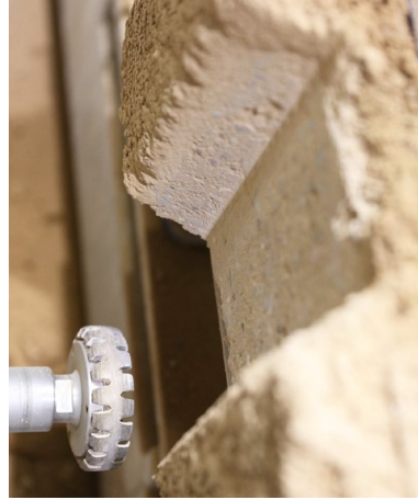
Abbildung 35: Subtraktive Nachbearbeitung von Stampflehm mittels Diamant Flächenfräser mit Ø 91mm
