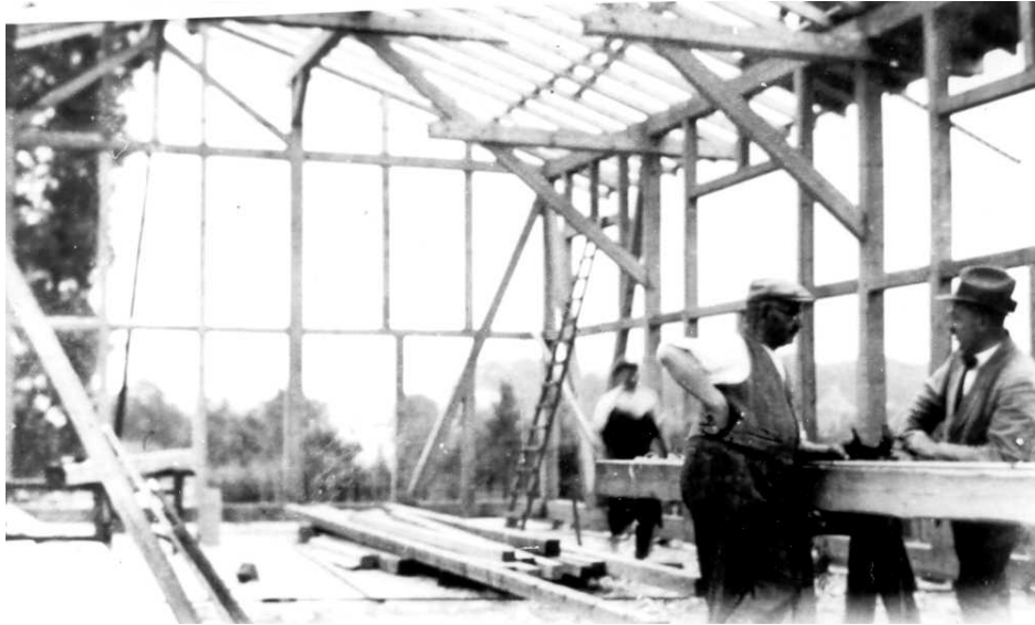
Erste Arbeiten an der Vereinseigenen Turnhalle
