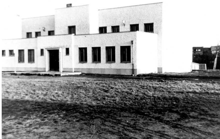
Die vereinseigene Turnhalle im Rohbau
