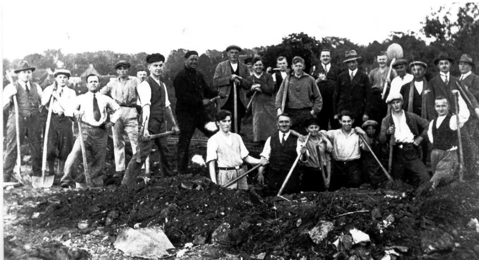
Arbeitseinsatz zum Bau der neuen Turnhalle
