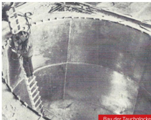
Bau der Tauchglocke
