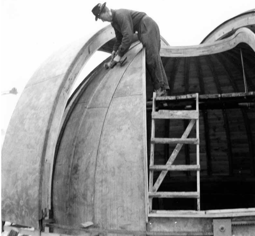
Bild 12: Die mit Kupfer verkleidete Holzkuppel der neuen Volkssternwarte wurde Ende 1960 von der Firma Heringer aus Rosenheim auf dem Dach des Schiller-Gymnasiums errichtet. (Foto: Privat)
