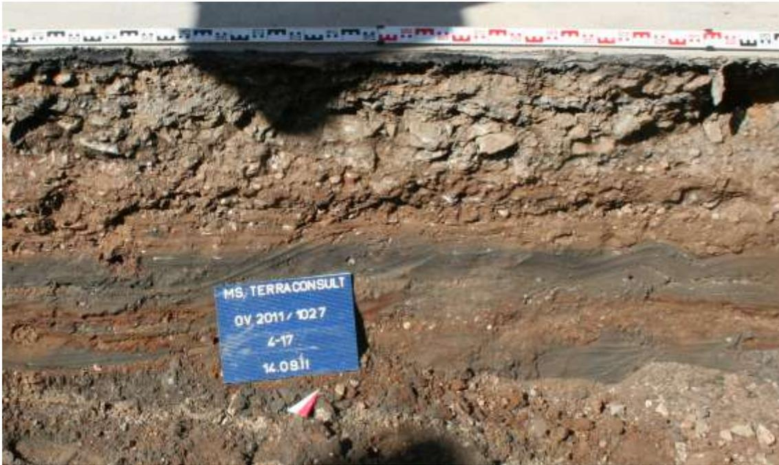
**Abb. 16:** Planierschichten des Straßenkörpers mit grauer, sandiger und verdichteter Schicht (Foto: E. Biermann)
