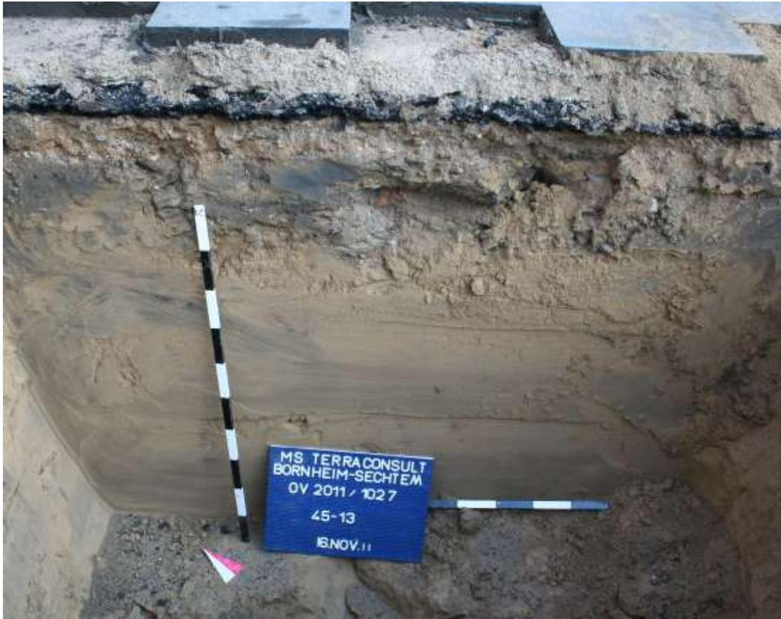
**Abb. 24:** Profil gegen Nordost der Stelle 45, Gehwegbereich, mit Plattenbelag, Asphaltdecke und Unterbau, direkt auf Löss aufliegend
