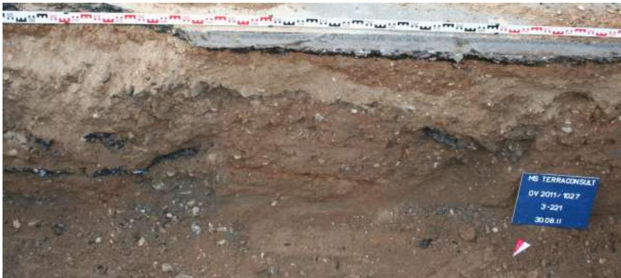
**Abb. 13:** Profilausschnitt mit eingelagerten Asphaltresten im Straßenkörper (Foto E.Biermann)
