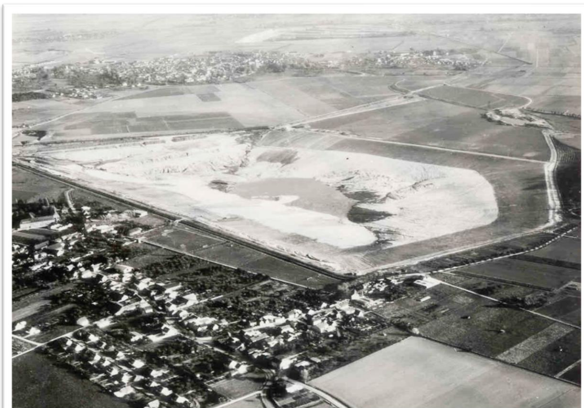
Restloch der „Grube Victor“ Mitte der 1960er Jahre in Füssenich.
