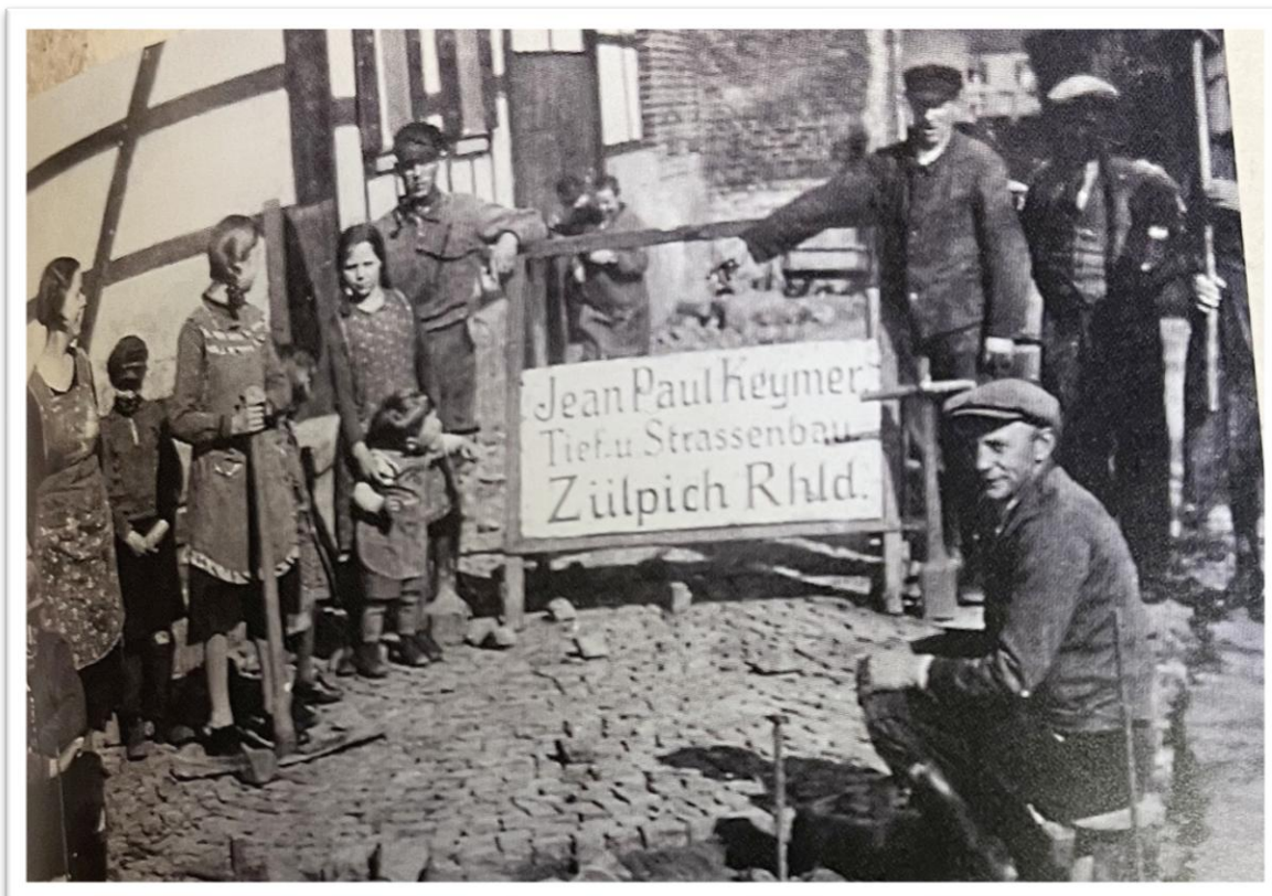
Straßenbau in Füssenich, Hauptstraße, 1914, Fotos: Sammlung Karl Kloock, Geich.
