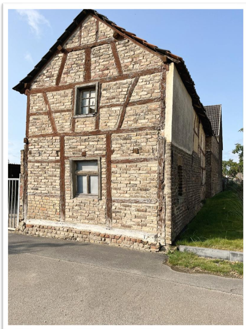
„Haus Cramer“, Dorfstraße/ heute Grabenstraße in Geich.
