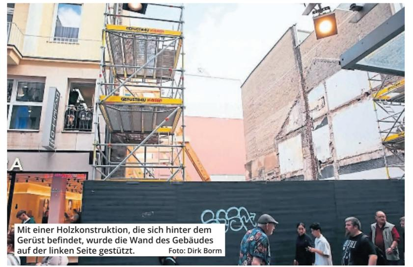
Mit einer Holzkonstruktion, die sich hinter dem Gerüst befindet, wurde die Wand des Gebäudes auf der linken Seite gestützt.
