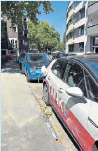
An der Herbert-Lewin-Straße 5 in Köln-Lindenthal wurden drei neue Ladebordsteine installiert. Foto: TankE GmbH
