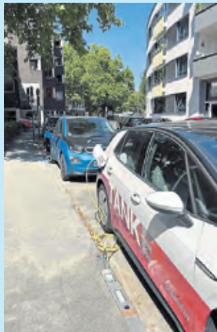
An der Herbert-Lewin-Straße 5 in Köln-Lindenthal wurden drei neue Ladebordsteine installiert. Foto: TankE GmbH
