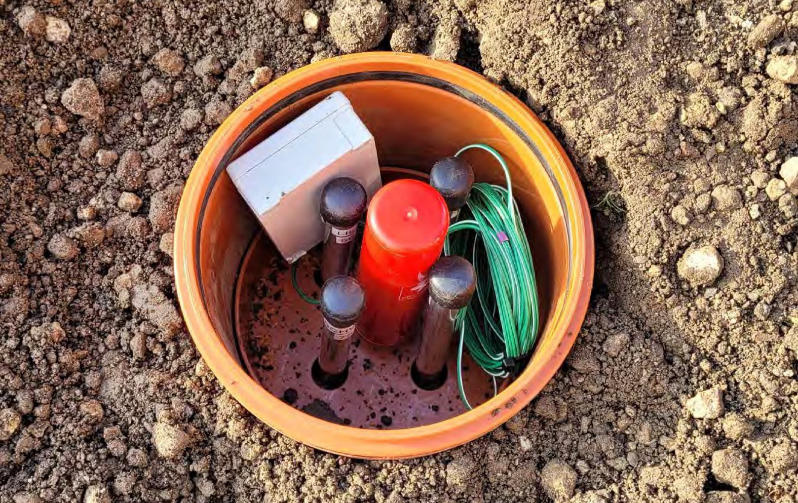
Die eingebauten Sensoren Quelle: co:met GmbH
