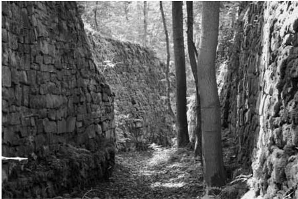
Abb. 3: Zugang zu einem Steinbruch im Hooptal (Landkreis Holzminden). Die hohen Wände stützen das dahinterliegende Abraumaterial. Aus diesem Steinbruch stammt auch das Material für das Zisterzienserkloster Amelungsborn (12. Jh.) (Foto: A. Hoppe)
