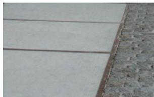
Beispielbild 1: helle Ort betonplatten, dunkle und bruchraue sowie starkfugige Pflasterung
