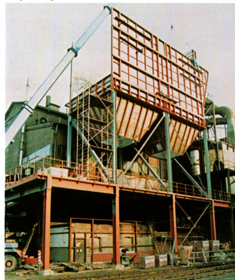
Montage des Stützgerüsts und der Seitenwände des E-Filter I
