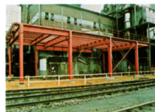
Stahlbau der Filterbühne
