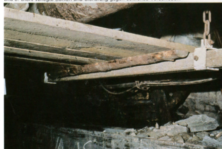
Bild 3: Dicht verlegte Bohlen und Sicherung gegen seitliches Verschieben.
