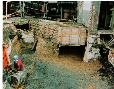
Aushub für die Fundamente und Blick auf den alten und neuen nördlichen Kabelkanal
