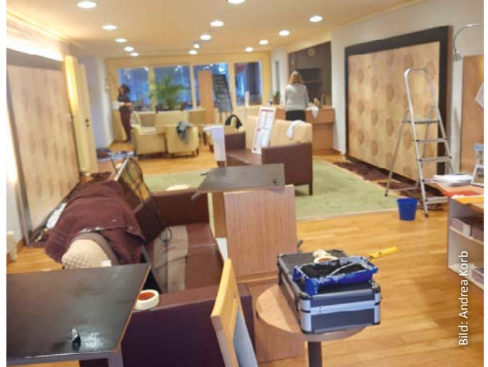
Die Renovierungsarbeiten sind in vollem Gange.
