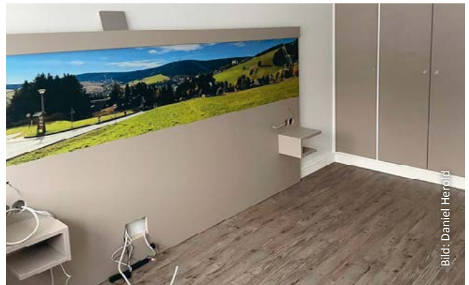
In den letzten Zügen der Renovierungsarbeiten.
