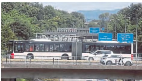
Diese Brücke der Frankfurter Straße über die B55a muss neu gebaut werden. Foto: Krasniqi
