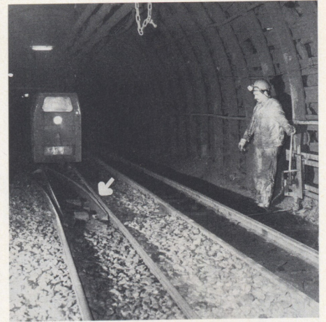
Aufschneiden von Weichen erhöht die Gefahren im Förderbetrieb!
