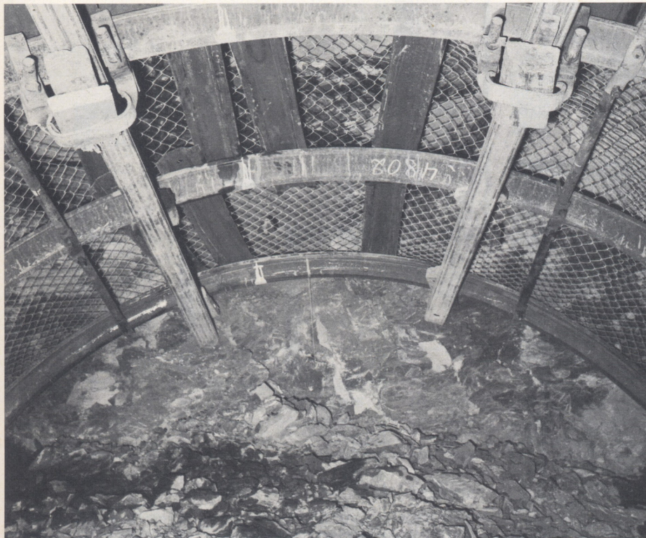
Firstsicherung bei gebrächem Gebirge
