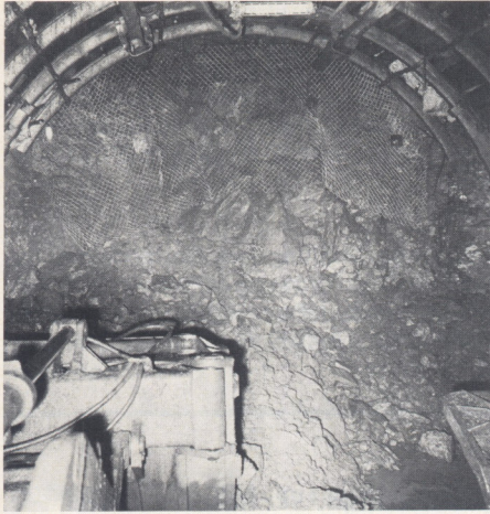
Ortsbrustsicherung gegen Steinfall
