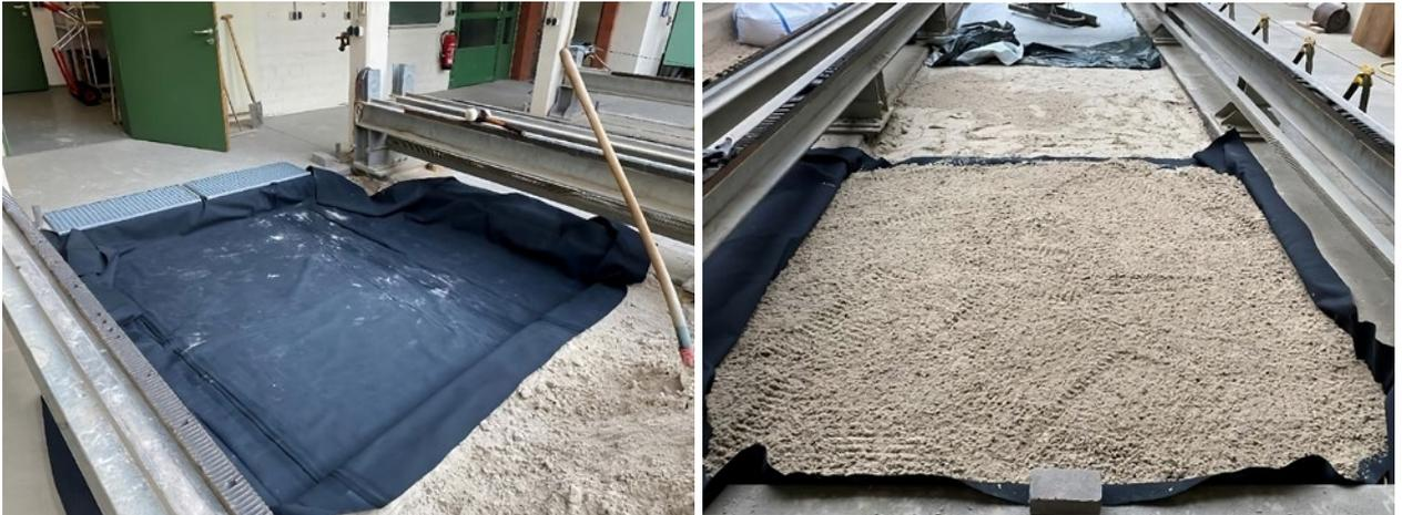
Abbildung 19: Versuchshalle – Herstellung des mit Folie abgedichteten Bereichs der Versuchsfläche (Borchers, 2023)
