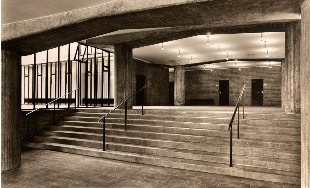
Abb. 25: „Eingangshalle mit Blick in den Innenhof“ (Anmerkungen auf der Rückseite, Foto: von der Ropp, 1967. HASTK, Best. 1466 (Ropp, Inge von der), Fo 156, Innenaufnahmen, [1967])
