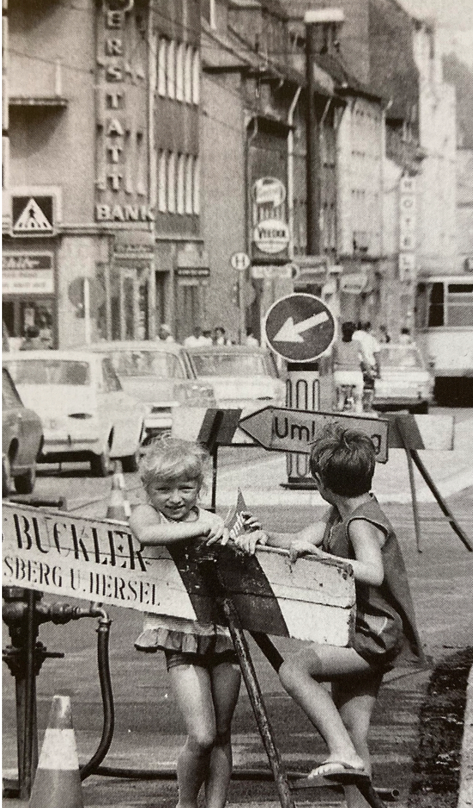
Abb. 5: Baumaßnahmen an der Hauptstraße im August 1970 (Steckner 2012: S. 68)
