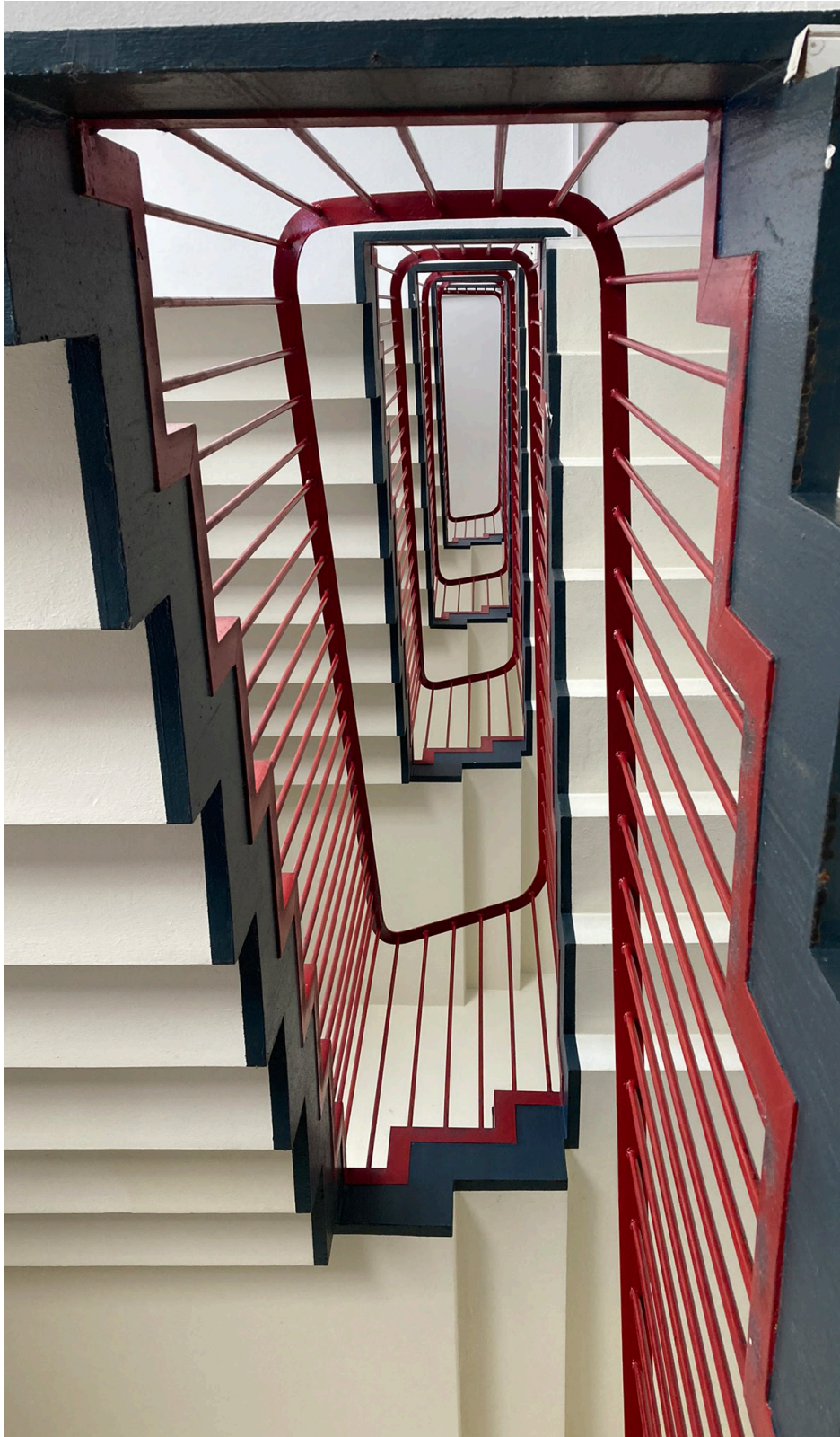
Abb. 49: Das Treppenhaus zieht sich über alle neun Stockwerke (Foto: Clara Grothkopp, Dezember 2021)
