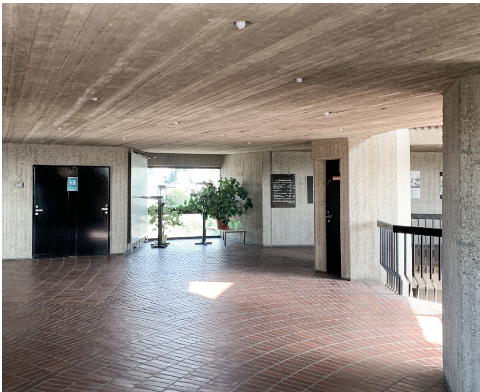
Abb. 83: Das Foyer des ersten Obergeschosses im Rathaus Bensberg mit rauer Schalung an der Decke, gestockter Betonoberflächen der Wände und Stützen und Tonziegeln als Bodenbelag (Foto: Merlin Veit-Dott, 2022)
