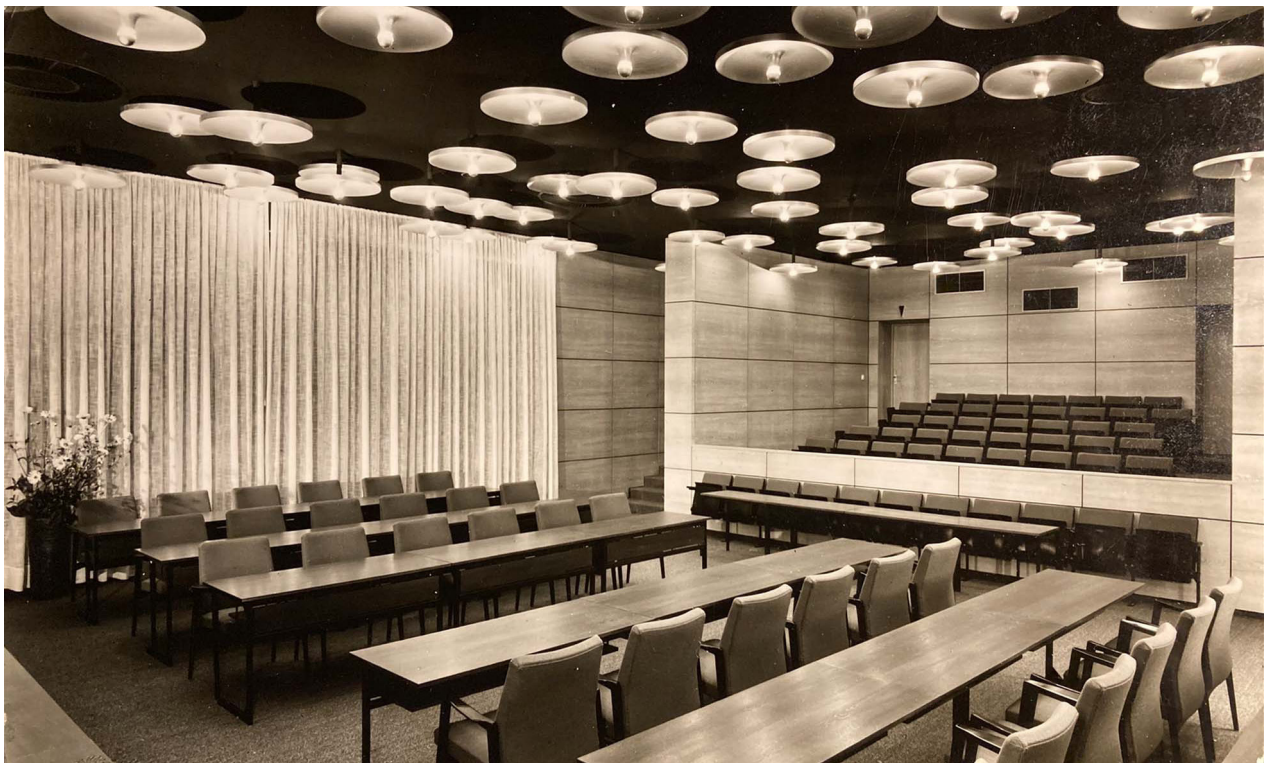
Abb. 63 (unten): Der Sitzungssaal mit originaler Möblierung und den metallenen Leuchten (Foto: Inge von der Ropp, 1967. HASTK, Best. 1466 (Ropp, Inge von der), Fo 156, Innenaufnahmen, [1967])
