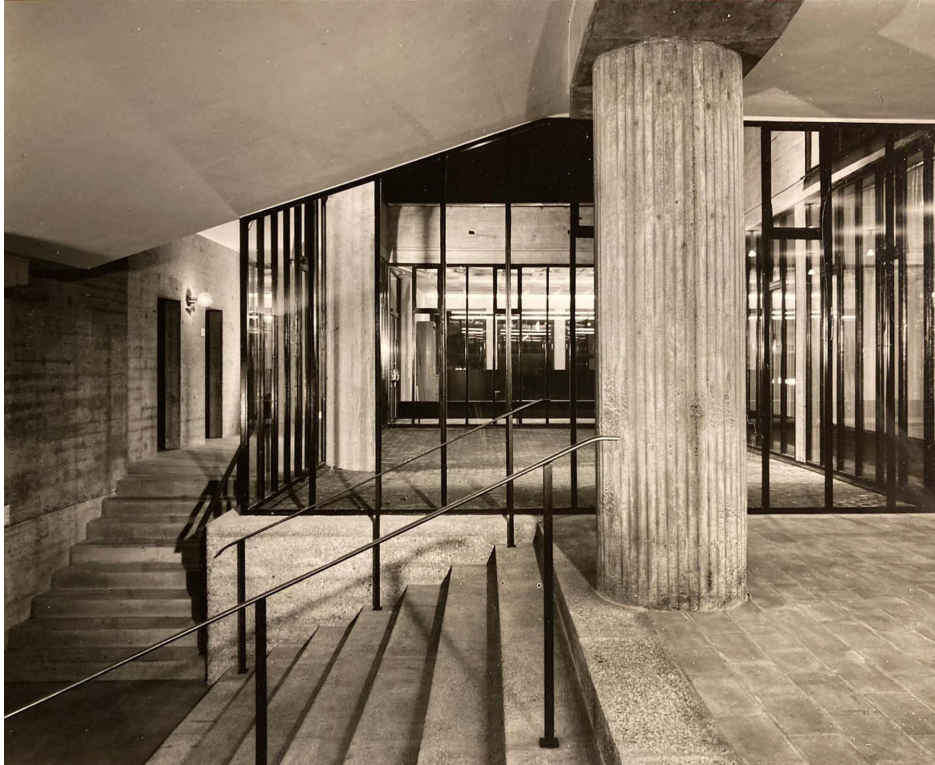
Abb. 82: Das Foyer des Rodenkirchener Rathauses mit rauer Schalung an den massiven Stützen, gestockter Betonoberflächen der Wände und Tonziegeln als Bodenbelag, Anmerkungen auf der Rückseite der Fotografie: „Eingangshalle vom Haupteingang her“ (Foto: Inge von der Ropp, 1967. HASTK, Best. 1466 (Ropp, Inge von der), Fo 156, Innenaufnahmen, [1967])
