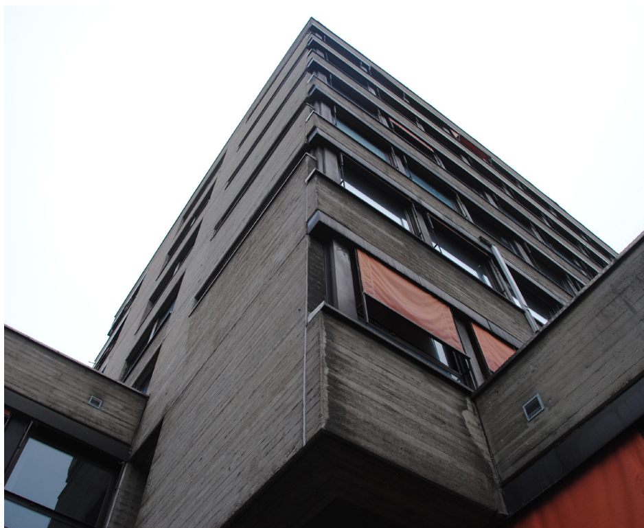
Abb. 87 (vorherige Seite) Die Westfassade mit dem auskragenden Sitzungskubus' des Rodenkirchener Rathauses (Foto: Clara Grothkopp, Dezember 2021)
