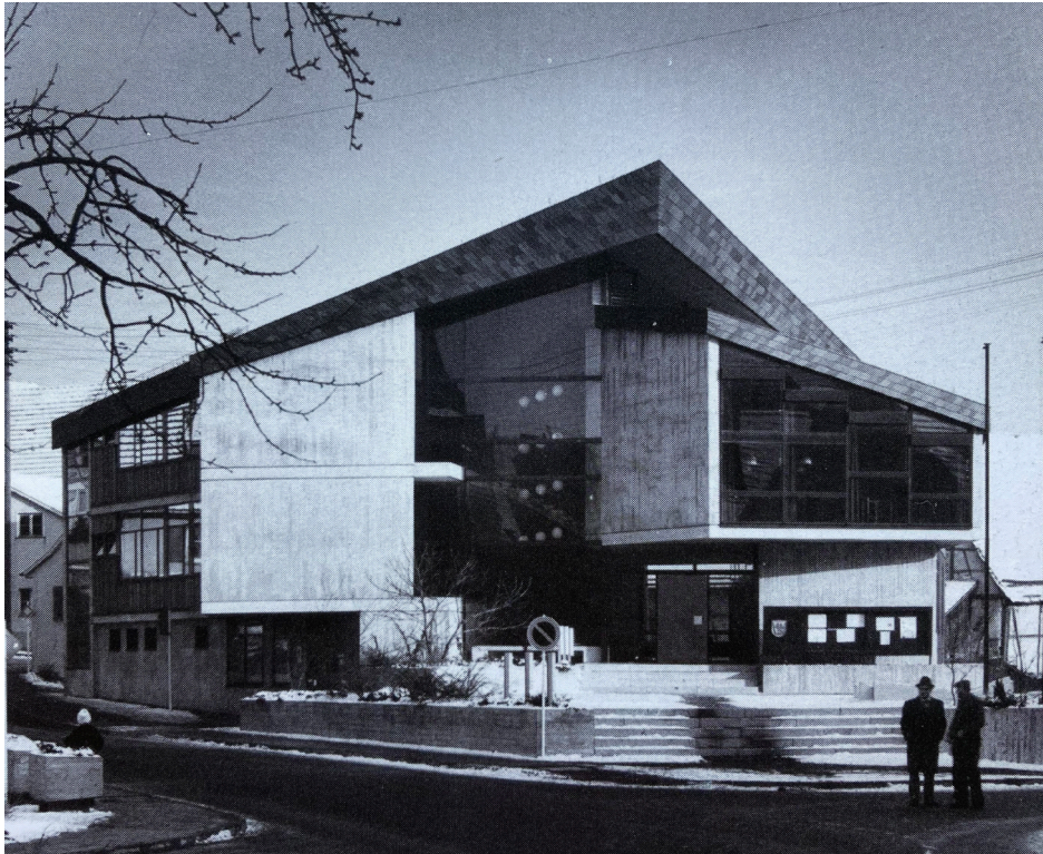
Abb. 79: Das Rathaus Dagersheim, rechts im Bild der verglaste Sitzungssaal mit Pultdach (Lange 2003: S. 55)
