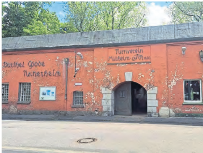
Die beiden Gebäude des MTV Köln unterscheiden sich stark voneinander. Fotos: Rika Kulschewski
