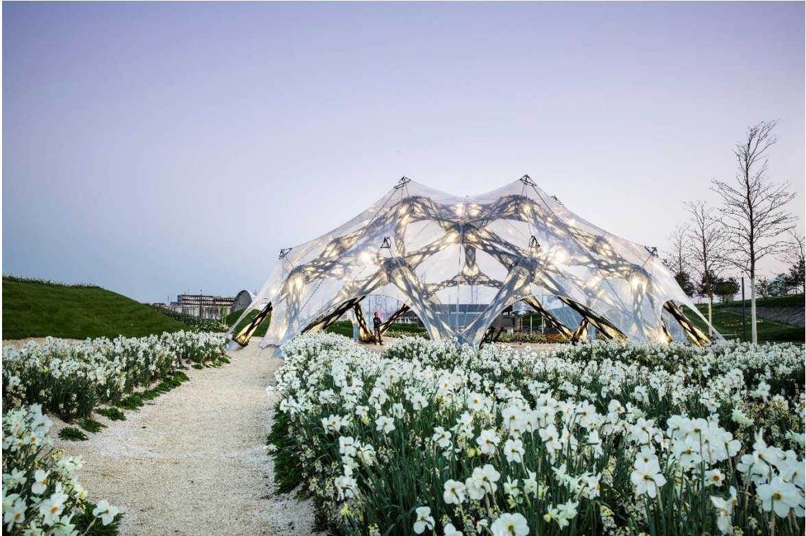
Abbildung 28: Basierend auf den in diesem Projekt entwickelten wissenschaftlich-technischen, integrativen Co-Design Herangehensweisen wurde eine Machbarkeitsstudie als Grundlage für Planung und Bau des BUGA-Faserpavillon 2019 auf der Bundesgartenschau in Heilbronn erstellt, um die Forschungsergebnisse und Anwendungspotentiale von leichten, robotisch gewickelten Dach- und Deckentragsystemen aus Faserverbundwerkstoffen öffentlichkeitswirksam darzustellen.
