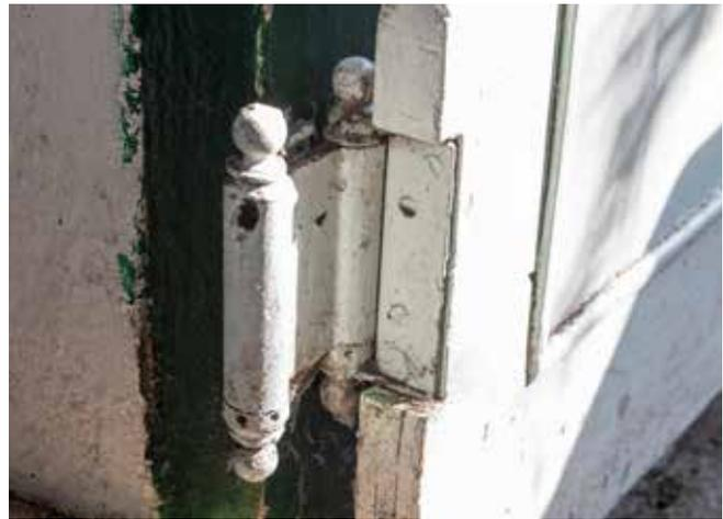
Die doppelflügelige Türanlage stellt ebenfalls eine Besonderheit dar. So ist diese zweischalig. Die äußere einbruchssichernde massive Doppeltür geht nach außen auf und kann mittels einer Stahlkette in Offenhaltung stehen. Die innere Doppeltür ist eine Schwingtür, das heißt beide Türelemente können sowohl nach innen als auch nach außen geöffnet werden. Der Zweck wird sicherlich gewesen sein, eine maximale Flexibilität in der Nutzung sowohl innen als auch außen zu ermöglichen.
