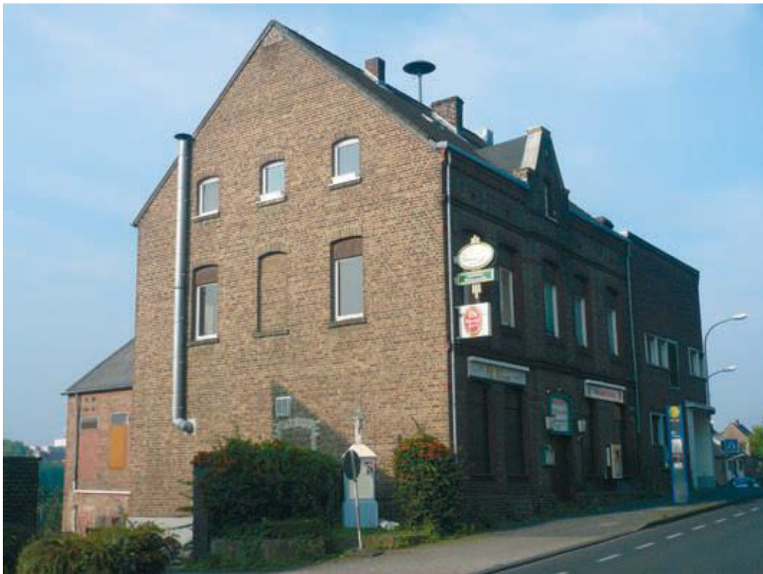
Gaststätte Regh in Kierberg (inzwischen abgerissen), Foto: Ulrich Wehrhahn.
