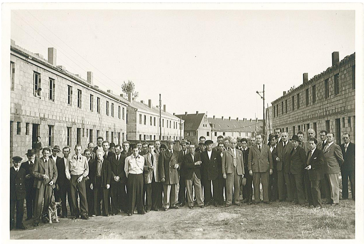
Am Eichenbusch, Bauphase, Stadtarchiv Brühl.
