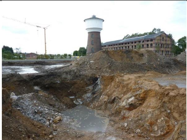
Abb. 170 Karbidschlamm nördlich des Wasserturms, 10.08.11
