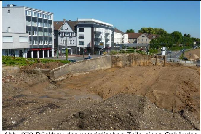
Abb. 372 Rückbau der unterirdischen Teile eines Gebäudes des Gemüsegroßhandels Pott, 30.05.18
