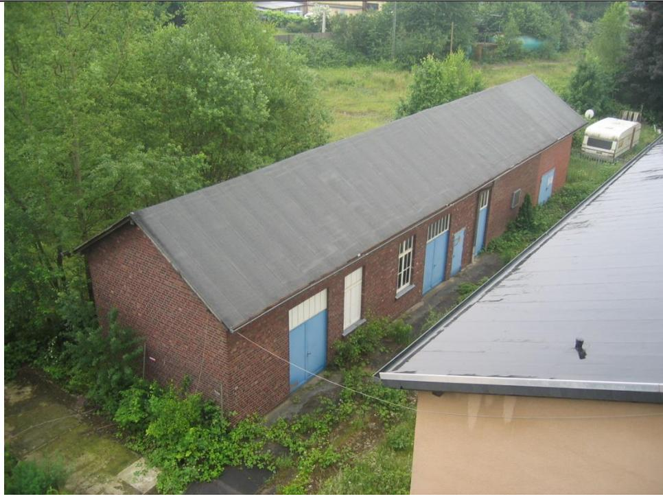
Abb. 60 Das Wasserwerk des Ausbesserungswerks wurde am 04.06.2008 vom Wasserturm aus aufgenommen. Rechts an den helleren Ziegeln ist der Anbau mit dem Aktivkohlefilter zu erkennen.
