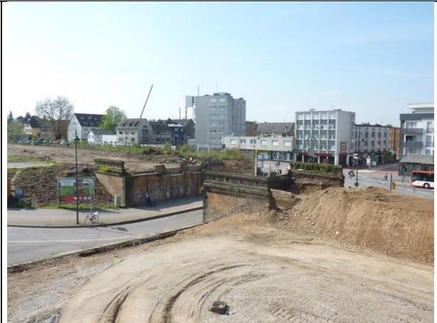
Abb. 366 Die Widerlager der Brücke Bahnhofsstr. werden auch noch der neuen Geländegestaltung weichen.. 07.04.18
