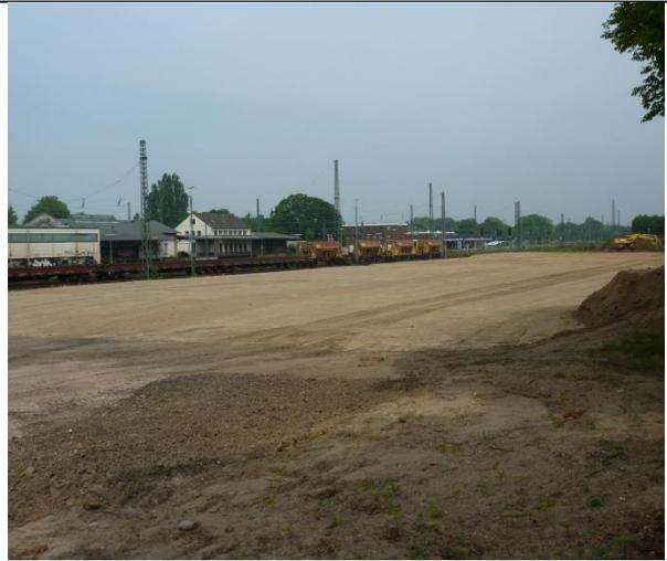
Abb. 164 Nachdem ca. die obersten 60 cm des Bodens des Güterbahnhofs abgetragen worden waren, wurde die Fläche bis auf Höhe der Werkstättenstr. mit neuem Material angeschüttet. 19.05.11
