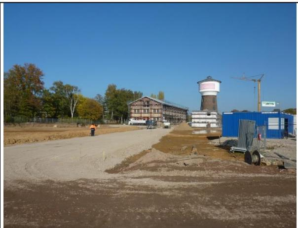
Abb. 174 Südlich des Magazins wurde die Tragschicht der Bahnstadtchaussee aus RCL-Material angelegt. Der Bodeneinbau für die Grünfläche läuft. Mit dem Anbau am Wasserturm wurde ebenfalls begonnen. 24.10.11
