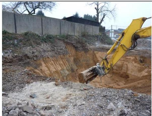
Abb. 156 Um diese Tankanlage wurde eine Bodenverunreinigung mit Kohlenwasserstoff festgestellt. Bis auf einen Rest, der sich nicht oberflächennah unter der angrenzenden Mauer befand, wurde die Verunreinigung aufgenommen und entsorgt. 01.02.11
