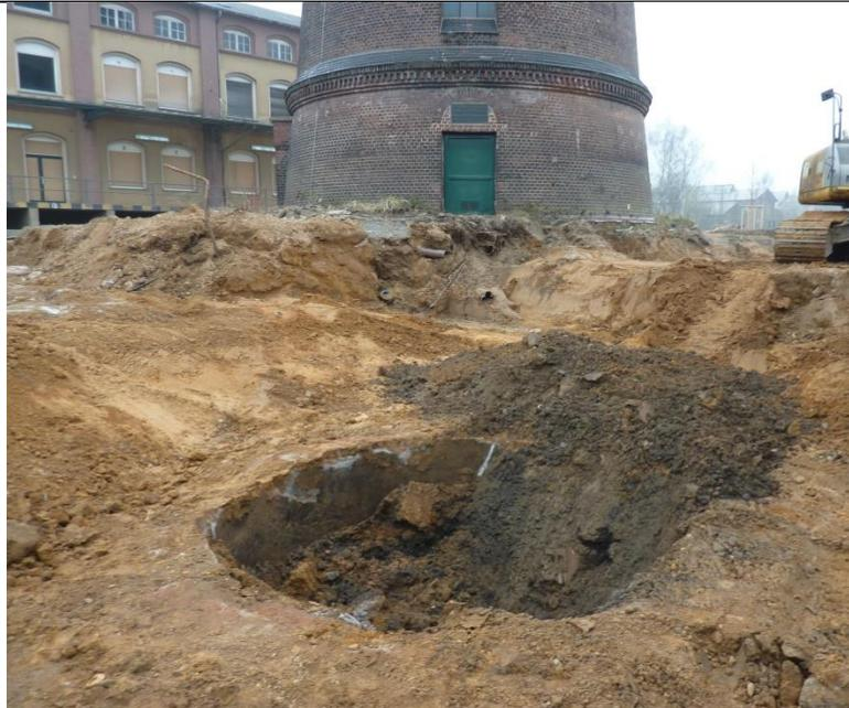
Abb. 58 Bei Rückbauarbeiten wurde der ehemalige verfüllte Förderbrunnen (siehe Abb. 68) freigelegt. 17.03.2011
