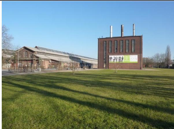
Abb. 52 Dort wo die Werbung hängt wurden die Fenster für einen Anbau zugemauert. Aus Gründen des Denkmalschutzes musste die Werbung entfernt werden. Alle drei Schornsteine sind hier noch vorhanden. 01.02.12
