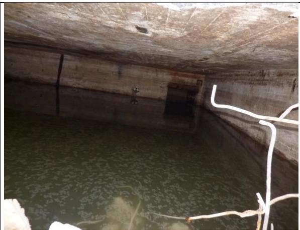
Abb. 238 Im nordöstlichen Bereich von Halle 2 befand sich der mit Wasser gefüllte Bunker 12. Die Decke des Bunkers wurde abgerissen, der Boden durchlöchert und anschließend wurde er mit Grauwacke verfüllt. 13.02.13
