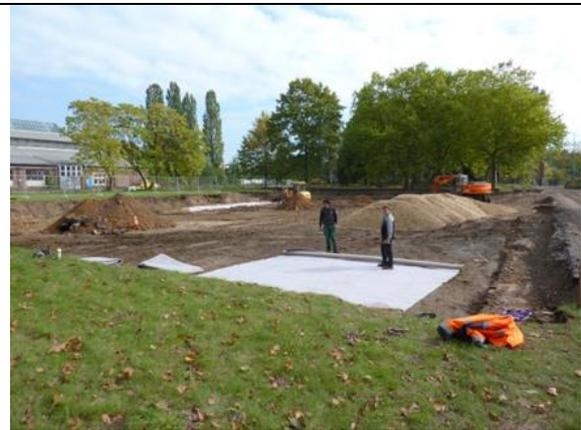
Abb. 153 Verlegung eines Geotextils als Schutzschicht unter der KDB, 22.09.10
