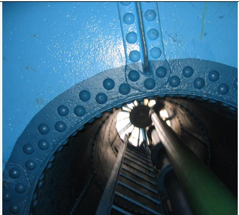
Abb. 66 Durchstieg durch den genietet Wasserbehälter
