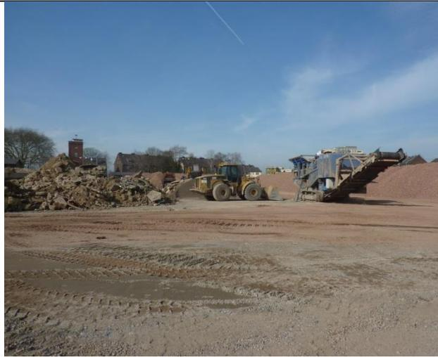
Abb. 242 Bauwerksreste wurden gebrochen und teilweise als RCL-Material wiederverwendet. 06.03.13
