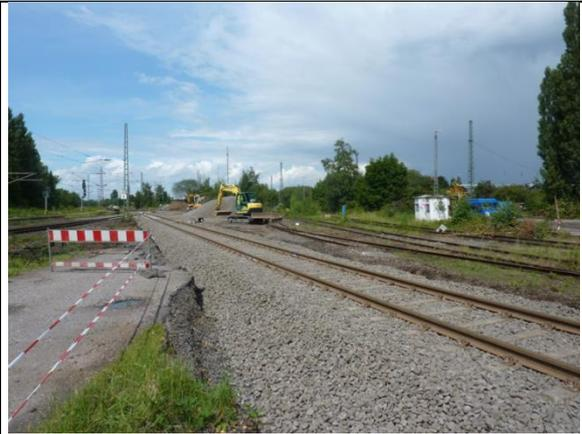
Abb. 391 Der Anschluss Bender wurde an die alte Güterzugstrecke verlegt. 30.07.12
