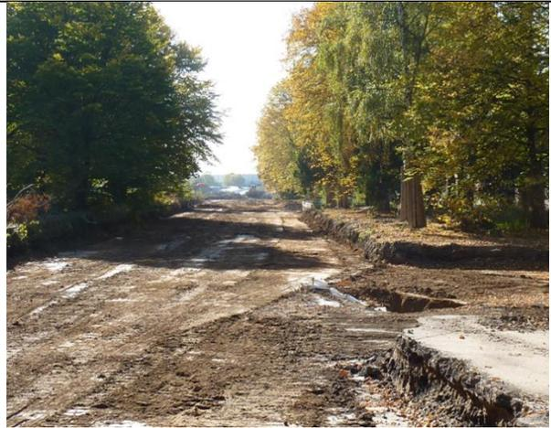
Abb. 192 ausgekofferte Teerölverunreinigung (rechts), 10.10.12
