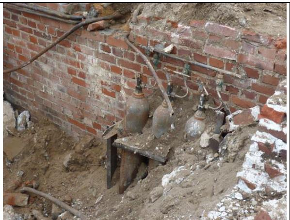
Abb. 250 Tankgrube mit CO<sub>2</sub>- Löschanlage im Bereich der Feuerwache, 28.08.13
