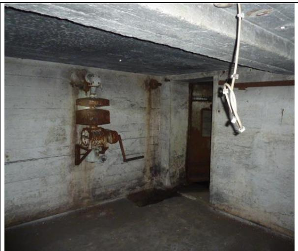
Abb. 247 Handbetriebene Lüftung mit Filtern im Bunker 3, 29.05.13
