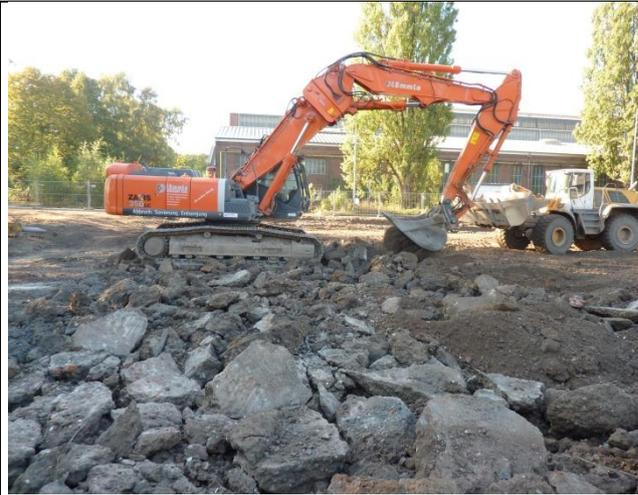
Abb. 150 Unter der Versiegelung befanden sich auch Bauwerksreste, die entsorgt werden mussten. 22.09.10
