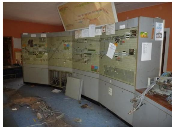
Abb. 312 Stelltafel des Drucktastenstellwerks
