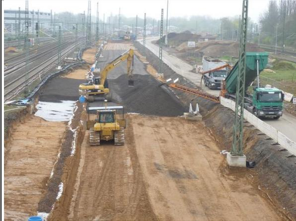
Abb. 348 Einbau der Planumsschutzschicht (PSS) südlich der Campusbrücke, 13.04.16
