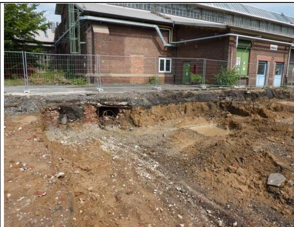
Abb. 140 Bei den Sanierungsarbeiten wurden nicht bekannte Wartungsgruben freigelegt. 12.08.10 Foto Ursel Tapernon-Franz
