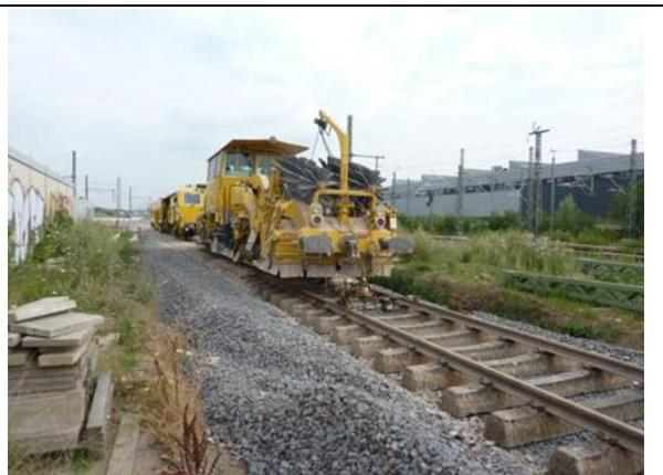
Abb. 393 Mit der Verlegung der Güterzugstrecke erhielt die Fa. Bender auch einen neuen Gleisanschluss. Durch den Einbau von 2 Weichen wurde die Gleislänge deutlich erhöht. 26.07.16
