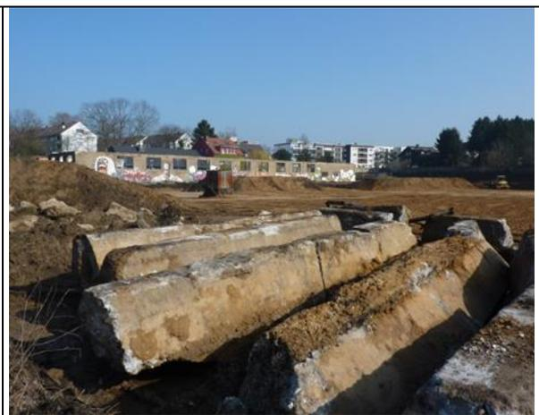
Abb. 158 Die Tanks der 2. Grube waren schon geschweißt. Im Hintergrund steht noch ein Teil der Halle (Vereinsheim) des Motorradclubs „Steppenwölfe“. Zwischen der Halle und den Tanks ist ein Brunnenhäuschen zu erkennen. Der Brunnen wurde fachgerecht verfüllt und verschlossen, 01.03.11
