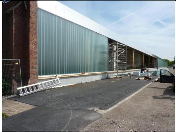
Abb. 285 Der nördliche Teil der Halle 1 erhielt nach Süden einen Wetter- und Betretungsschutz aus einer durchgehenden Glaswand. 29.04.15
