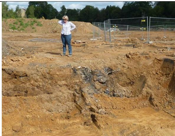
Abb. 171 Verunreinigung mit Teeröl nördlich vom Wasserturm, 10.08.11
