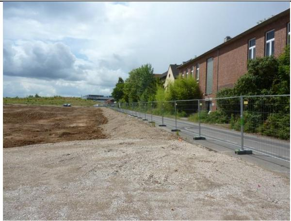
Abb. 283 Die Werksstr. erhielt zur Sicherung eine Böschungsanschüttung aus RCL-Material. 30.06.14
