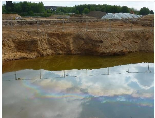
Abb. 166 Ölschlieren auf einer Wasserfläche, 04.05.11
