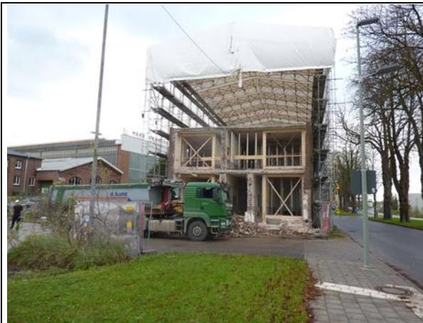
Abb. 291 Das Satteldach des Verwaltungsgebäudes ist auf diesem Foto schon abgebaut. Es wurde inzwischen durch eine neue Etage mit Flachdach ersetzt. 25.10.17
