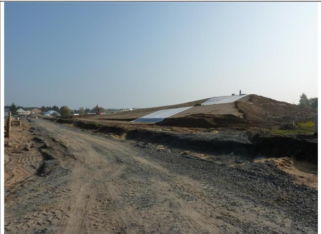
Abb. 198 Das Landschaftsbauwerk Süd wird mit einer KDB abgedichtet. 24.10.12
