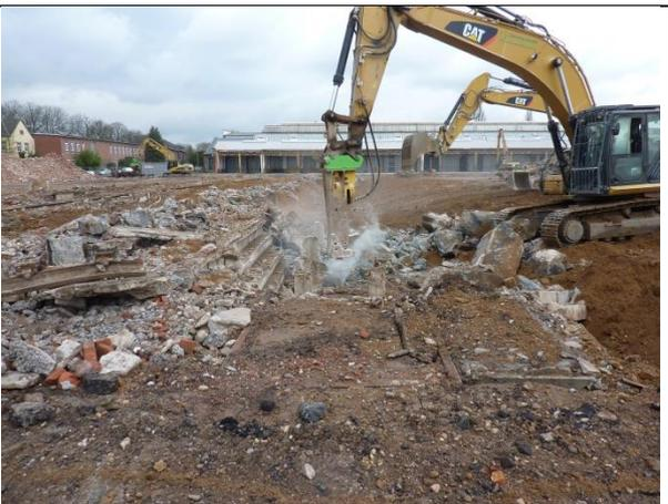
Abb. 269 Rückbau der Wartungsgrube in Gleis 10, 26.02.14
