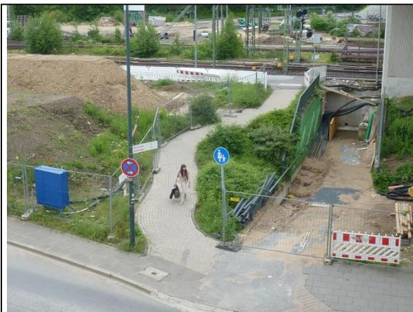
Abb. 346 Der westliche Tunnelzugang wurde nach Verlegung von Leerrohren verschlossen. Während der Modernisierungsarbeiten im Bahnhof existierte ein Behelfszugang zu Gleis 1 , 03.06.16
