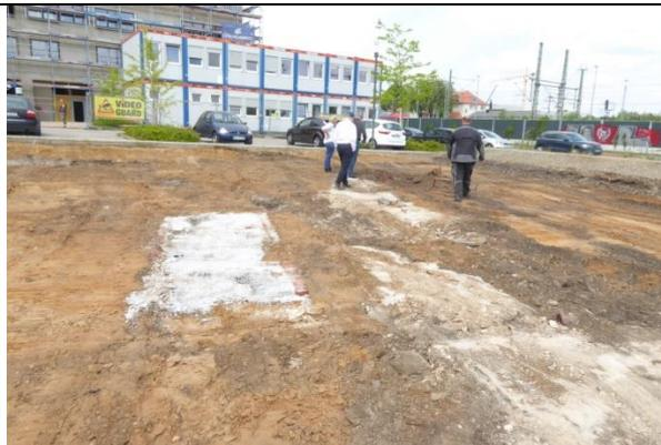
Abb. 385 Fundamente auf dem zukünftigen Kita-Gelände, die noch ausgebaut werden mussten, 10.05.22
