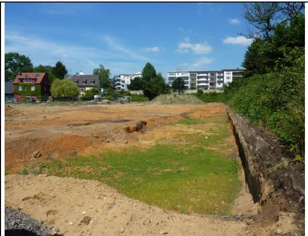
Abb. 162 Die Fläche des Quartiers am Campus ist fast vollständig mit sauberem Boden wieder angefüllt worden. Rechts ist ein Richtung Kolberger Str. verlaufendes Streifenfundament zu erkennen. Ob hier eine Kranschiene gelegen hat, ist nicht bekannt. 01.06.11
