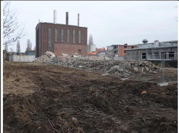
Abb. 128 Der Rückbau des Waschhauses ist schon abgeschlossen. Das Abbruchmaterial lagert im Vordergrund. Rechts erkennt man die Rückseite des Casinos. 04.02.10 Foto Ursel Tapernon-Franz
