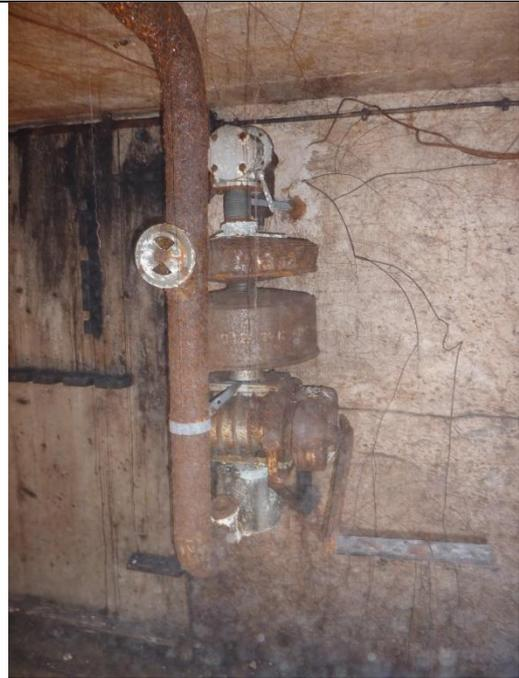
Abb. 281 Im Schutzraum befand sich noch eine handbetriebene Lüftungsanlage. 06.06.14
