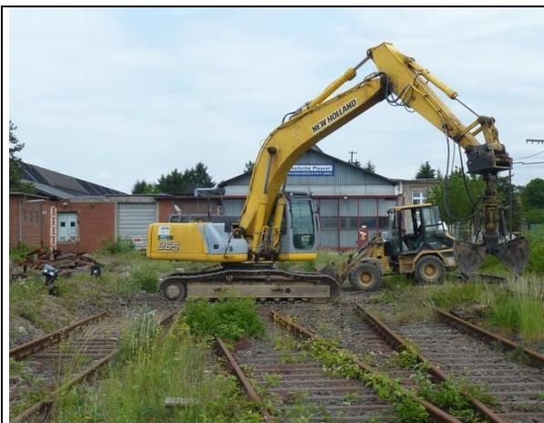
Abb. 167 Während der Bodensanierung des 2. BA wurde im südlichen Gleisbauhof mit dem Gleisrückbau begonnen. 18.05.11
