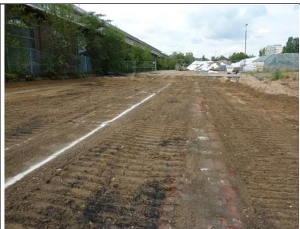
Abb. 217 Die drei Fundamente bestanden aus Beton. Direkt neben dem Mittelfundament verlief auch ein Fundament aus Ziegeln. Vermutlich wurden in der Vergangenheit Änderungen an den Fundamenten der Schiebebühne vorgenommen. 10.08.11
