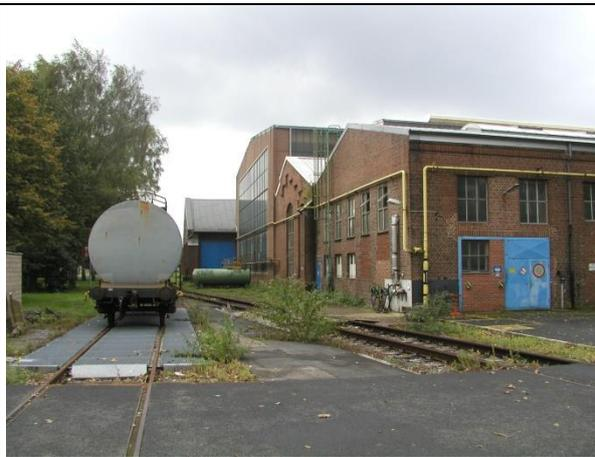
Foto B32 gesicherte Abstellfläche für den Waggon mit Trafoöl in Gleis 32
