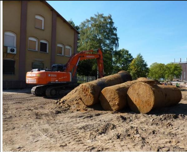
Abb. 146 Die Tanks in der 1. Grube waren genietet und wurden vermutlich in der Kesselschmiede des Aw hergestellt. 22.09.10
