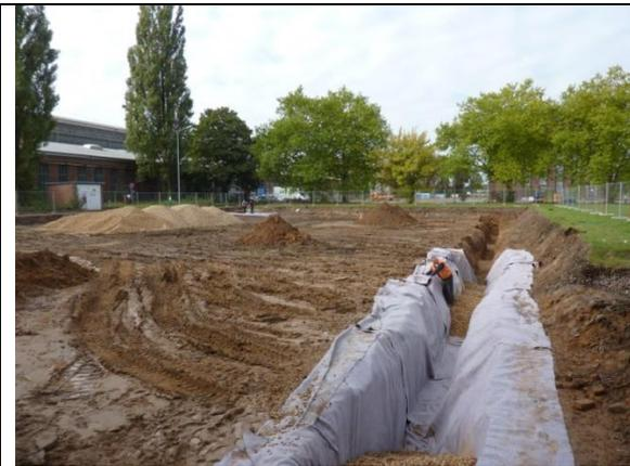
Abb. 152 Bau der Rigolenentwässerung, 22.09.10
