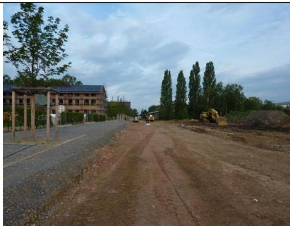
Abb. 173 Der Straßen- und Wegebau der Bahnstadtchaussee hatte schon begonnen. Links ist als Wegeunterbau RCL-Material verwendet worden. 03.08.11
