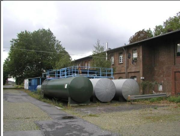
Foto B44 In den Tanks wurden die Abwässer der Waschanlagen bis zur Reinigung in einer mobilen Emulsionsspaltanlage zwischengelagert.
