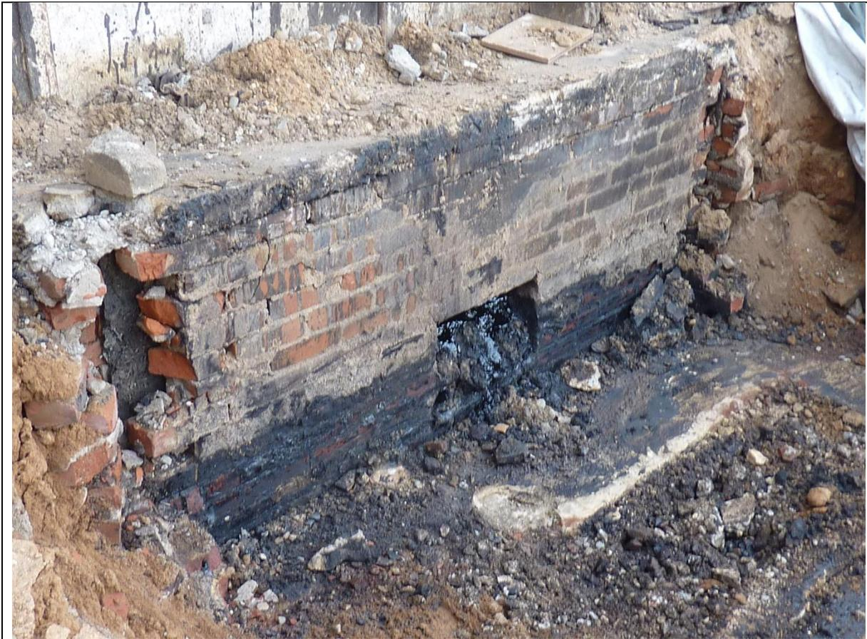
Abb. 137 Das Teeröl und der verunreinigte Boden wurden entsorgt. 16.09.11
