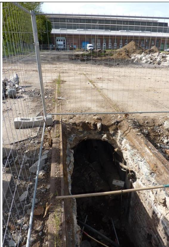
Abb. 119 Verbindungsgang zwischen den Hallen 1 und 2 unter Gleis 18. Der Gang war auch in den beiden Hallen unter diesem Gleis vorhanden. Im Hintergrund steht Halle 1. 05.05.10
