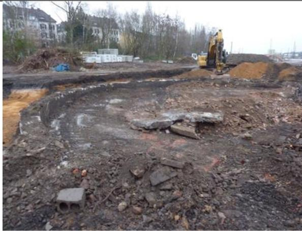
Abb. 361 Die Grube der kleinen Drehscheibe (d=16,2 m) des Bw Opladen wurde freigelegt. 36.01.15
