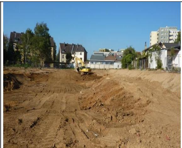
Abb. 253 Mit dem Einbau von sauberem Boden ist im Bereich der ehem. Anheizhalle begonnen worden. 30.09.13
