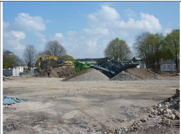
Abb. 275 Anschließend erfolgt die Zerkleinerung in einer mobilen Bauschuttrecyclinganlage. 24.03.14
