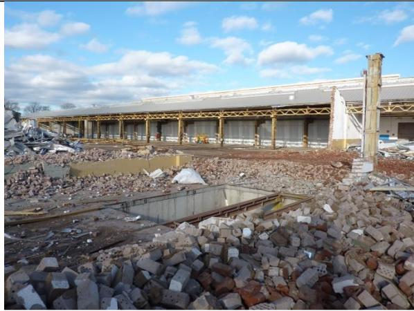
Abb. 264 Zwischen den verbliebenen Schiffen 4 und 5 des nördlichen Hallenteils wurde als Wetterschutz durchgängig eine Kunststoffolie eingebaut. 28.01.14
