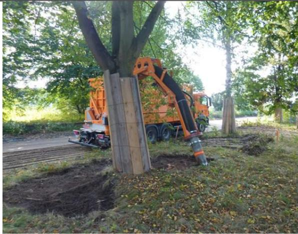
Abb. 191 Um die Bäume im Nord-Süd Grünzug nicht zu beschädigen wurde hier die obere Bodenschicht von einem Saugbagger-Lkw aufgenommen. 19.09.12
