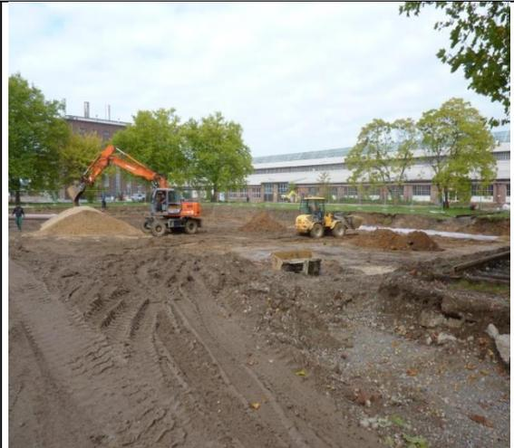
Abb. 151 Herstellung eines Planums für die KDB, 29.09.10
