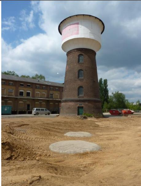
Abb. 69 Bei der Bodensanierung wurde der ehem. Förderbrunnen und das Speicherbecken des Wasserwerks verschlossen. 04.05.11
