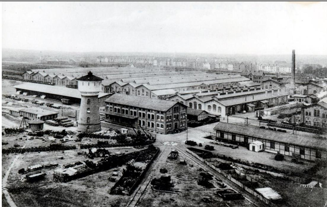
Abb. 68 Aw Opladen um 1910: Links neben dem Wasserturm liegt der Brunnen (Rundbau), aus dem der Behälter im Turm mit Wasser befüllt wurde. Foto: Stadtarchiv Leverkusen
