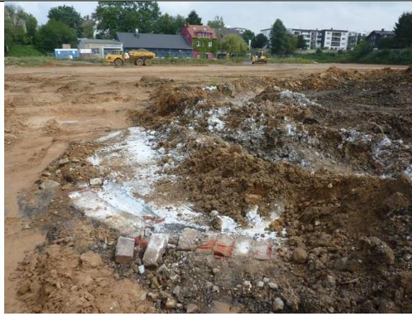
Abb. 169 Während des Bodeneinbaus waren die noch vorhandenen Bodenverunreinigungen zu beseitigen. Karbidschlammgrube 27.07.11
