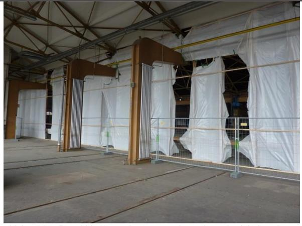
Abb. 265 Der Wetterschutz wurde schon bald durch Wind beschädigt. 11.02.14
