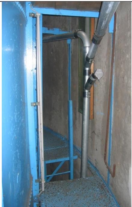
Abb. 65 Wasserbehälterumlauf mit verschlossenen Sichtöffnungen nach Außen
