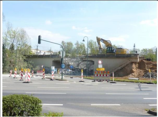
Abb. 378 Rückbau Brücke Lützenkirchener Str. 17.04.18
