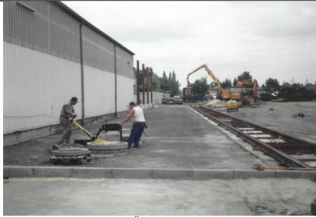
Abb. 390 Einbau einer Ölabscheideranlage auf der neuen Zerlegungsfläche für Lokomotiven, 23.07.01
