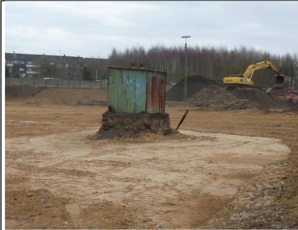
Abb. 159 Der Boden um dieses Brunnenhäuschen ist schon großflächig abgetragen. Rechts wird das früher angefüllte Bodenmaterial gesiebt. 10.03.11
