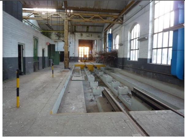
Abb. 259 ehemalige Raddruckwaage, Gleis 4, 14.01.14
