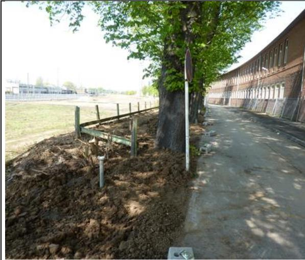
Abb. 163 Der Boden um die Kastanien an der Werkstättenstr. wurde mit einem Saugbagger-Lkw aufgenommen und neu angeschüttet. 07.04.11
