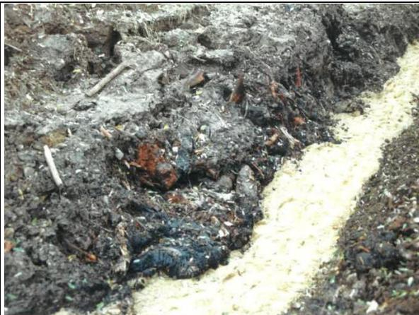
Abb. 6 aus den Grabenwänden austretende Säureharze, 16.11.2000
