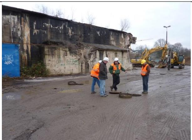
Abb. 223 Vor dem Hochbunker war eine Zisterne angeordnet, die auch über einen Anschluss für die Werksfeuerwehr verfügte. Die Zisterne wurde verfüllt nachdem der Boden durchlöchert worden war. 05.12.12
