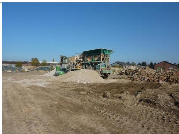
Abb. 179 Abbruchmaterial wurde in mobilen Bauschuttrecyclinganlagen zerkleinert und bei Eignung nach der Genehmigung durch die Untere Wasserbehörde häufig z.B. im Straßenbau wiederverwendet. 24.10.11
