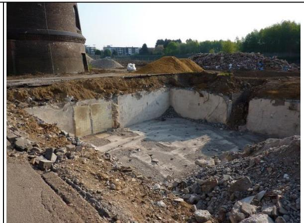
Abb. 126 Die Bodenplatte des Kellers des Ausbildungszentrums der Gleisbauer wurde durchlöchert, damit nach Verfüllung das Regenwasser versickern kann. 28.04.10
