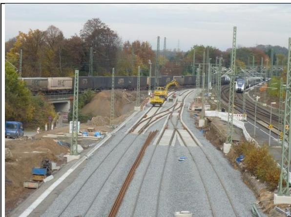
Abb. 352 Einschotterung der Gleise nördlich der Bahnhofsbrücke, 04.11.16
