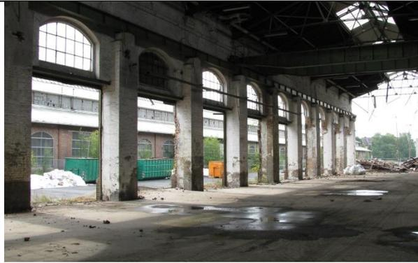
Abb. 105 Die westliche Wand der Triebwagenhalle (ehem. Kesselschmiede) ist schon geöffnet, und die Tore sind ausgebaut. 15.09.09
