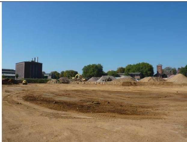
Abb. 252 Im Bereich der Halle 2 sind die Bodenfüllungen von Anfang der 1900er Jahre fast vollständig abgetragen. 04.09.13
