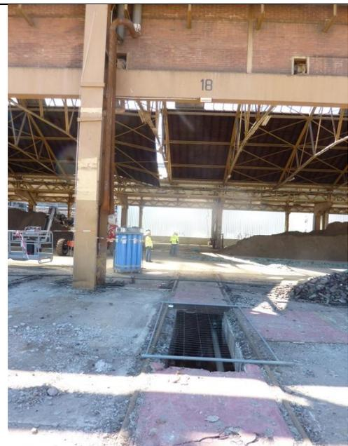
Abb. 296 Mit Versorgungsleitungen ausgefüllter Gang unter Gleis 18, 15.05.19
