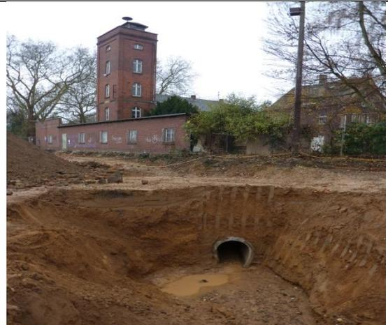
Abb. 255 Nördl. der Historischen Feuerwache wurde ein alter Kanal freigelegt. Auf diesem Foto ist auch gut der Falkennistkasten zu erkennen. 27.11.13
