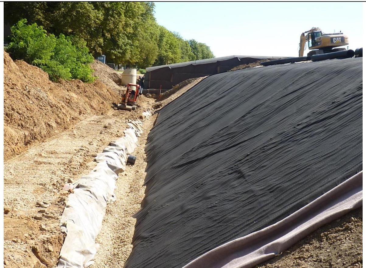
Abb. 196 Auf das Kiesbett am Fuß der Rampe wurden die oben rechts zu erkennenden Rigolen-Rohre verlegt und mit Kies überdeckt. 23.07.12
