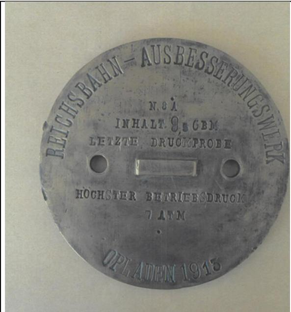
Abb. 104 Nach der Reinigung war u.a. die Beschriftung „Reichsbahnausbesserungswerk Opladen 1913“ zu erkennen. Dies lässt den Schluss zu, dass die genieteten Tanks in der werkseigenen Kesselschmiede produziert wurden. Das Schild befindet sich heute im Stadtarchiv. 20.09.19
