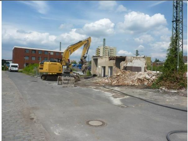
Abb. 335 Das Batterie- und Trafogebäude wird abgebrochen, während das Schulungsgebäude im Hintergrund noch steht. 23.07.15
