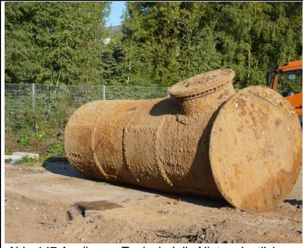
Abb. 147 An diesem Tank sind die Niete deutlich zu erkennen. 22.09.10
