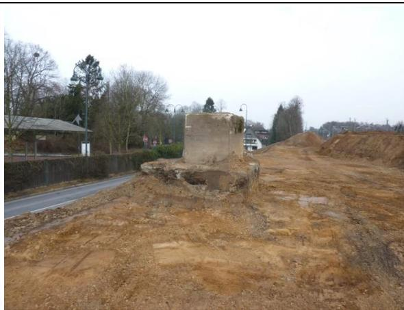
Abb. 373 Fundament eines Fahrleitungsmastes, 19.02.18
