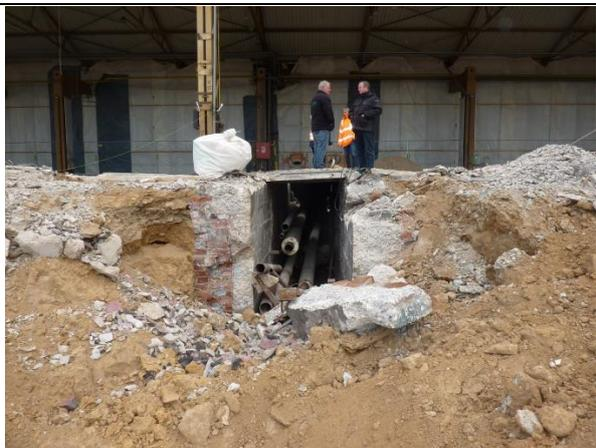
Abb. 278 Hier sieht man den Gang unter Gleis 18 im Übergang zum nördlichen Hallenteil mit mehreren Leitungen. 15.04.14
