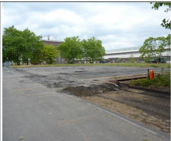
Abb. 148 Die oberste Schicht der Versiegelung war am 04.08.10 abgefräst und entsorgt worden. Foto Ursel Tapernon-Franz
