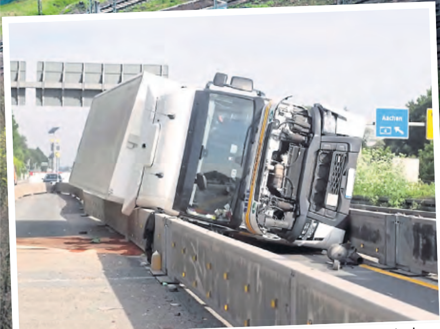
Die Autobahn-Baustelle auf der maroden Brücke am Eifeltor geriet in den letzten Wochen manchen LKWs zum Verhängnis.
