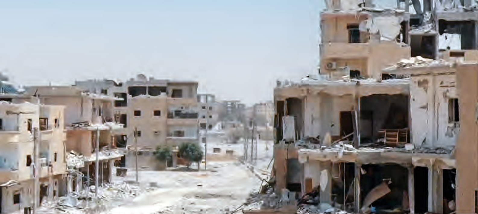
△ Teile der im Bürgerkrieg weitgehend zerstörten Stadt Ar-Raqqah
