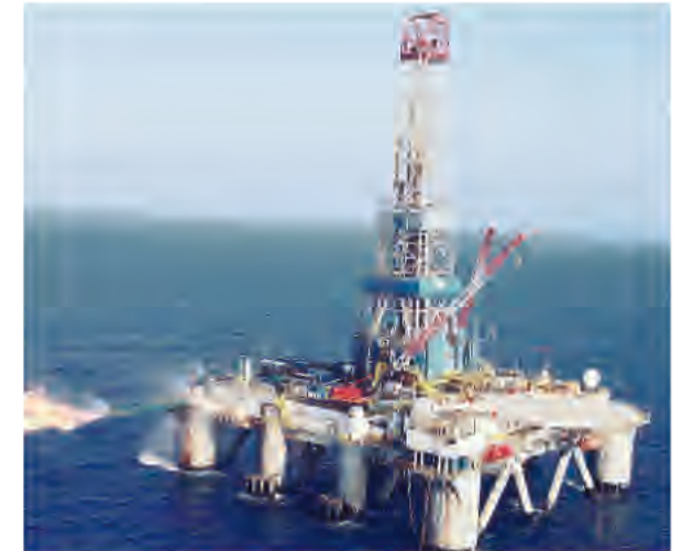
△ Förderturm des Gasfeldes Noa North vor der Küste von Ashkelon
