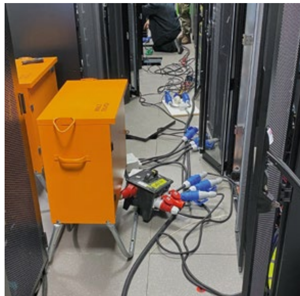
△ Abb. 4: Alternative Stromversorgung für die Server. (Quelle: ZGeoBw)
