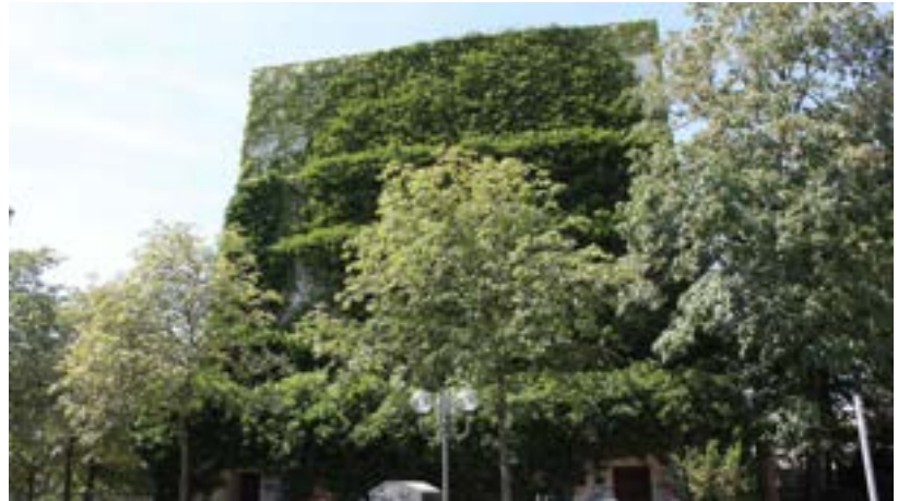
Abb. 39: Aussenansicht Windeckbunker Quelle: Isabel Klotz/Bundesstadt Bonn
