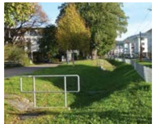
Muldenversickerung im Freiburger Stadtteil Vauban Quelle: berchtoldkrass
