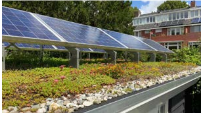
Abb. 41: Dachbegrünung und Solarpanele Quelle: Ren Notenbomer/Adobe Stock
