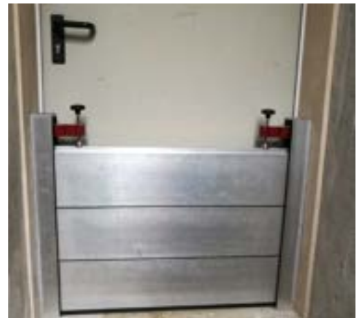
baulicher Überflutungsschutz Quelle: berchtoldkrass
