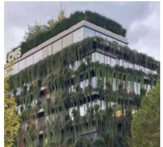
Fassadenbegrünung, Stuttgart; Quelle: berchtoldkrass
