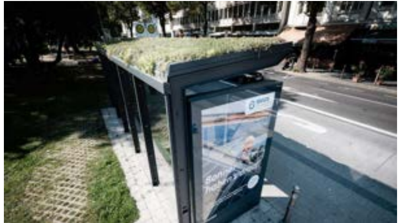
Abb. 48: begrüntes Wetterschutzhäuschen Quelle: Martin Magunia/Stadtwerke Bonn
