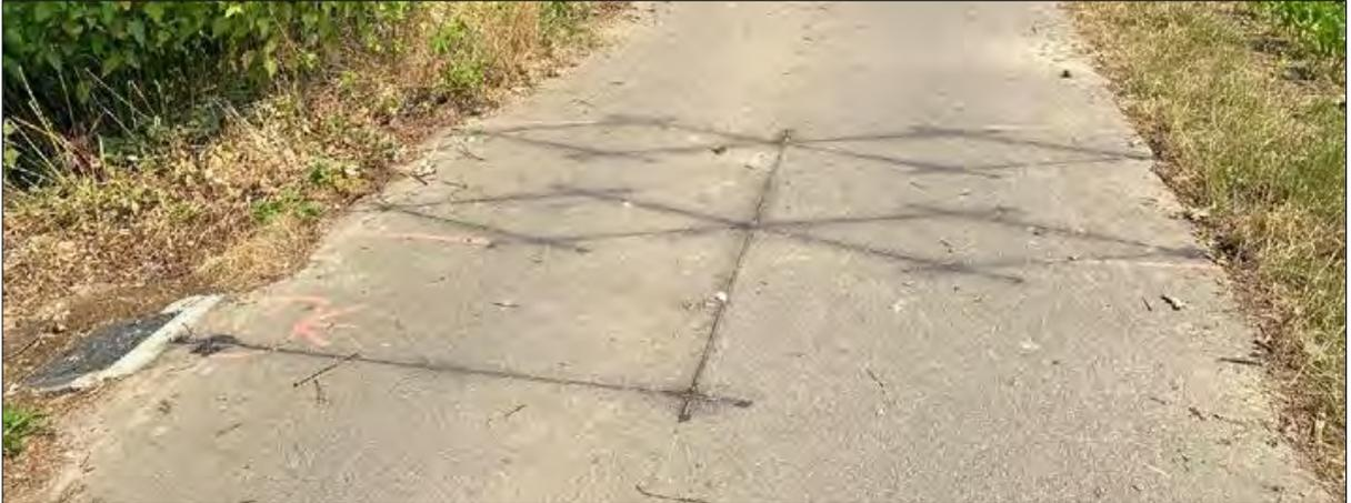
Bild einer eingebauten Zählstelle (Schleife) mit Bodentank (links)
