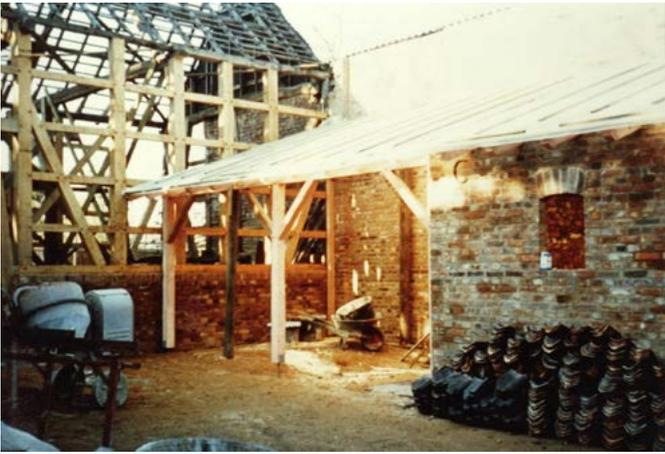
Die Dächer der Gebäude wurden mit alten Dachziegeln neu eingedeckt und mit Strohpuppen unterfüttert. Die alten Dachziegel haben die Vereins-Handwerker von einem Dach in Gürzenich abgedeckt und im Heimatmuseum wieder aufgelegt, natürlich mit Hilfe eines Dachdeckers.
