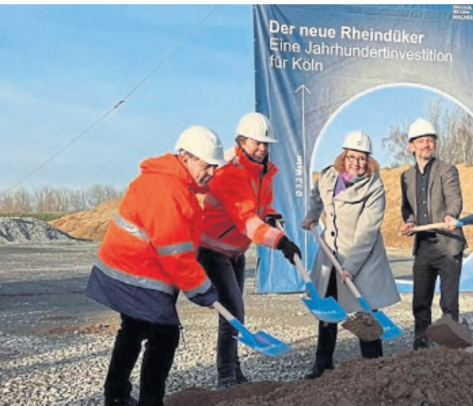
Der erste Spatenstich für den Rheindüker erfolgte bereits im Januar 2024. Foto: Ingo Schmitz
