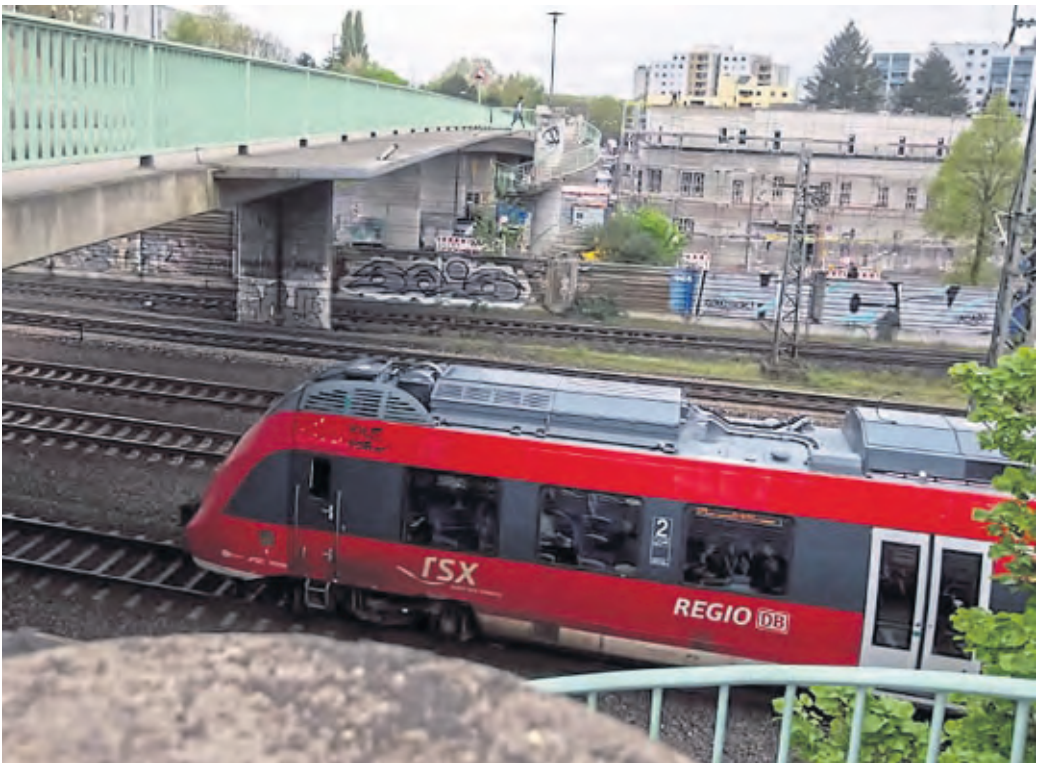
Die Bergerbrücke ist in die Jahre gekommen. Sie soll abgebrochen und neu gebaut werden.
