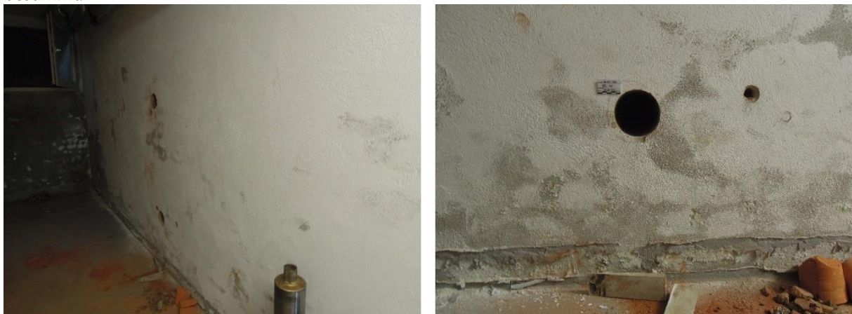
Abbildung 47: Situation einer Wandfläche nach der Bohrkernentnahme. Hier gut zu sehen die starke Belastungssituation an einer Kellerwand der Grundschule. Die Situation hinter der Wand ist unbekannt. Durch starke Feuchte- und Salzbelastung ist die aufgetragene Farbe an einigen Stellen schon abgängig, ebenfalls gut erkennbar an dem weißen Pulver auf dem Boden am Fuße der Wand. Im rechten Bild ist gut zu sehen, wie die Farbe sich deutlich vom Untergrund löst. Lokal sind auskristallisierte Salze auf der Oberfläche erkennbar.
