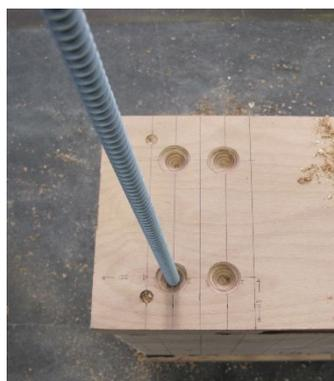
Abbildung A- 18: Eindrehen der Vollgewindeschrauben
