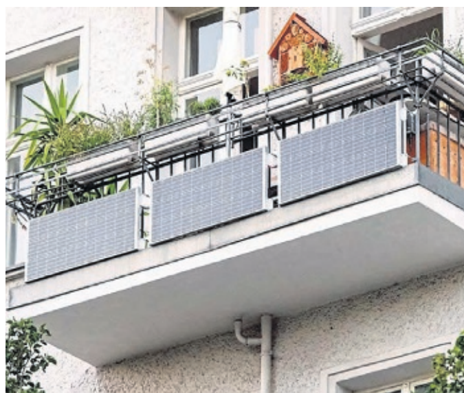
Eigentümer und Mieter haben seit 2024 einen Anspruch auf die Installation eines Balkonkraftwerks. Foto: Bernd Diekjobst/dpa-mag
