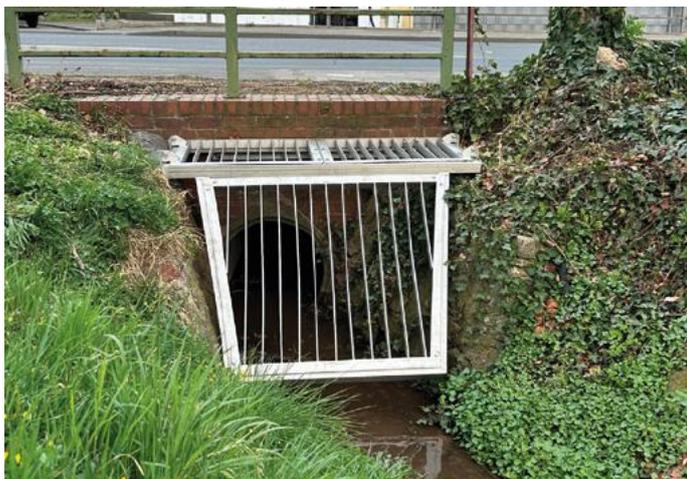
Der neue räumliche Rechen am Umbach in Sinzenich entspricht den aktuellen technischen Standards für ein solches Bauwerk und soll eine Verklausung der Rohrleitung bei starker Wasserführung verhindern.
